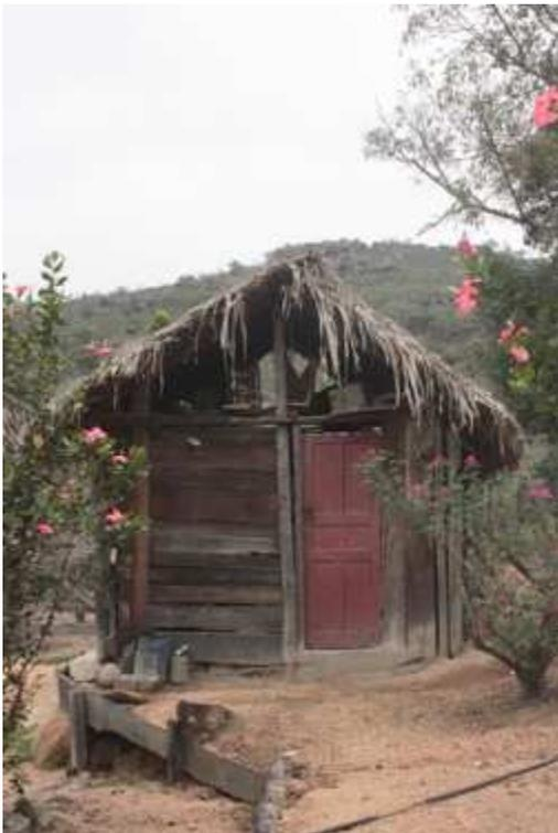
Figura 86: Paiol de madeira com cobertura de palha.
