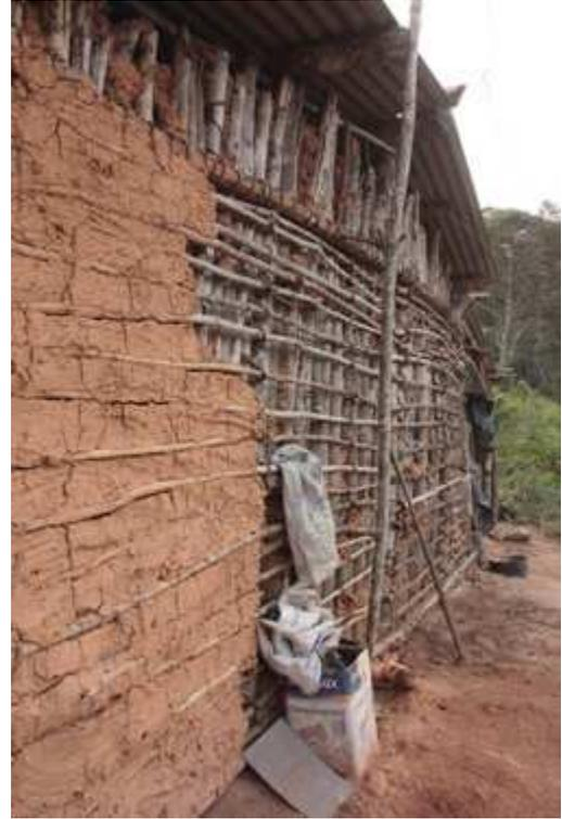
Figura 46: Parede externa que não está inteiramente revestida com barro vermelho.
