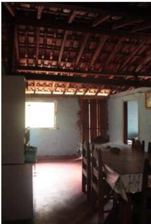
Figura 105: Sala da casa, piso de cimento queimado e cobertura em telha cerâmica.
