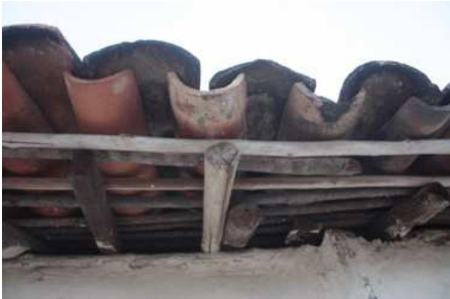
Figura 41: Estrutura do telha com peças de madeira de tamanhos irregulares.
