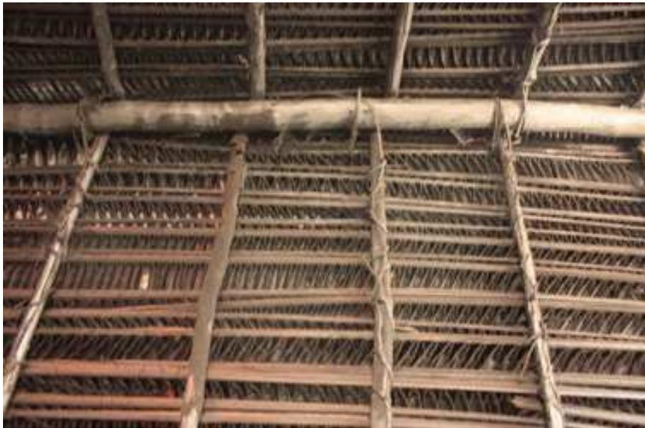
Figura 84: Cobertura de palha da cozinha vista de dentro, com sinais de fuligem do fogo.
