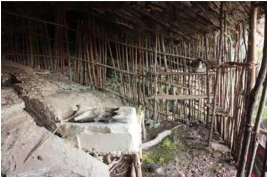
Figura 49: Presença de fornalha, fechamento com peças de madeira e girus para armazenamento.
