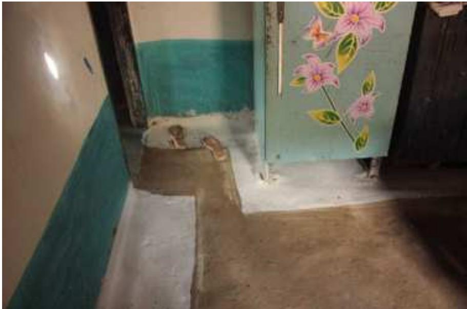
Figura 98: Piso da cozinha, barreado com barro branco e camada delineada de estrume de boi.
