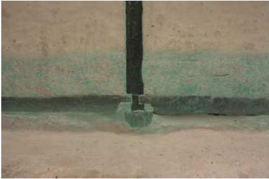
Figura 83: Detalhe do encaixe da madeira do esteios.
