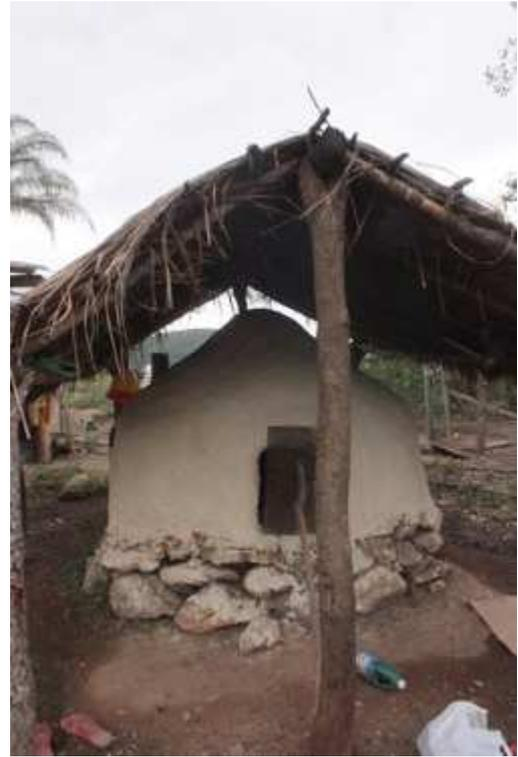
Figura 39: Forno à lenha após o barreamento.
