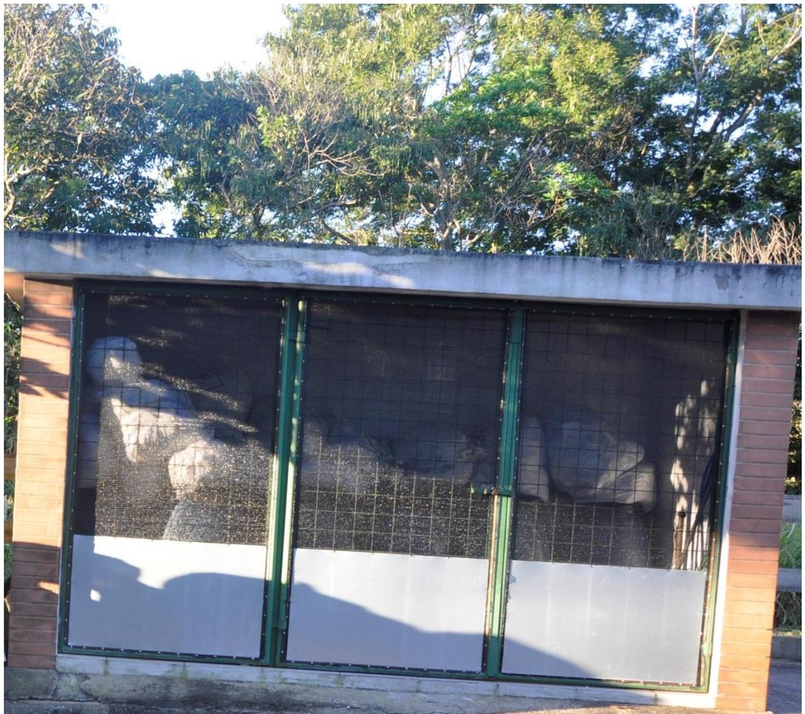
**Figura 6: Recuperação do espaço reservado a armazenagem do resíduo infectante A4 e E, com execução de revestimento em azulejo, colocação de ponto de água e mangueira para lavagem, implantação de tela e barreira contra roedores e outros vetores, pintura e fechamento por cadeado.**
