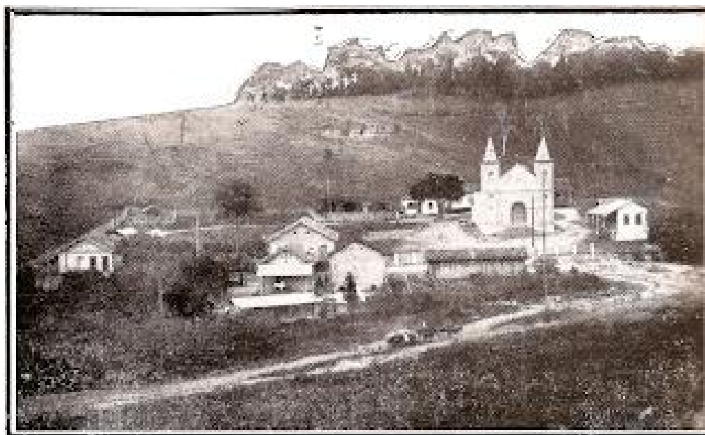
Figura 15 - Vista da Colônia de São Pedro
