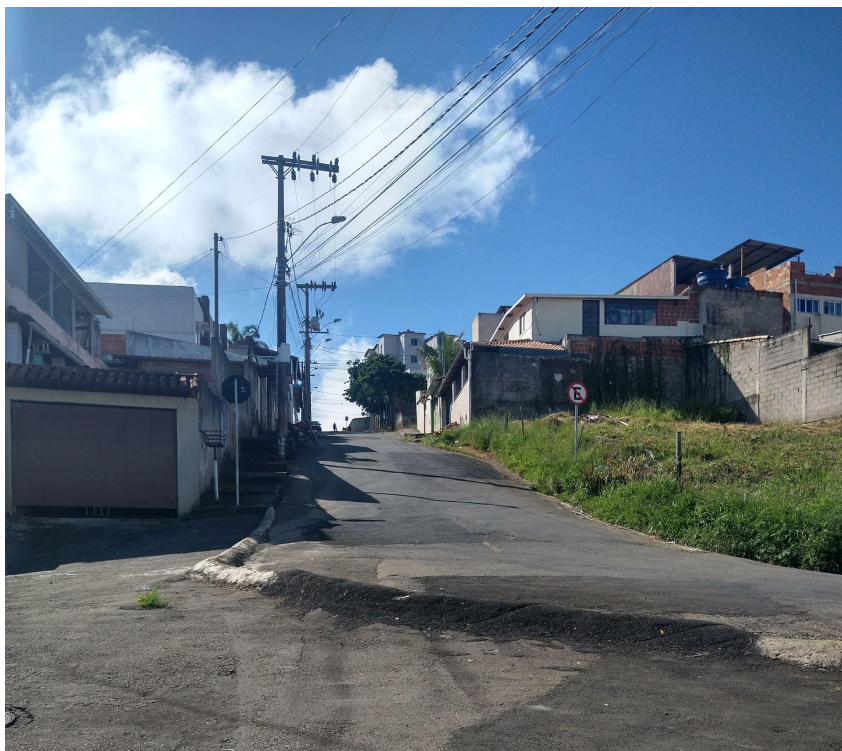
Figura 44 - Barragem construída por moradores
