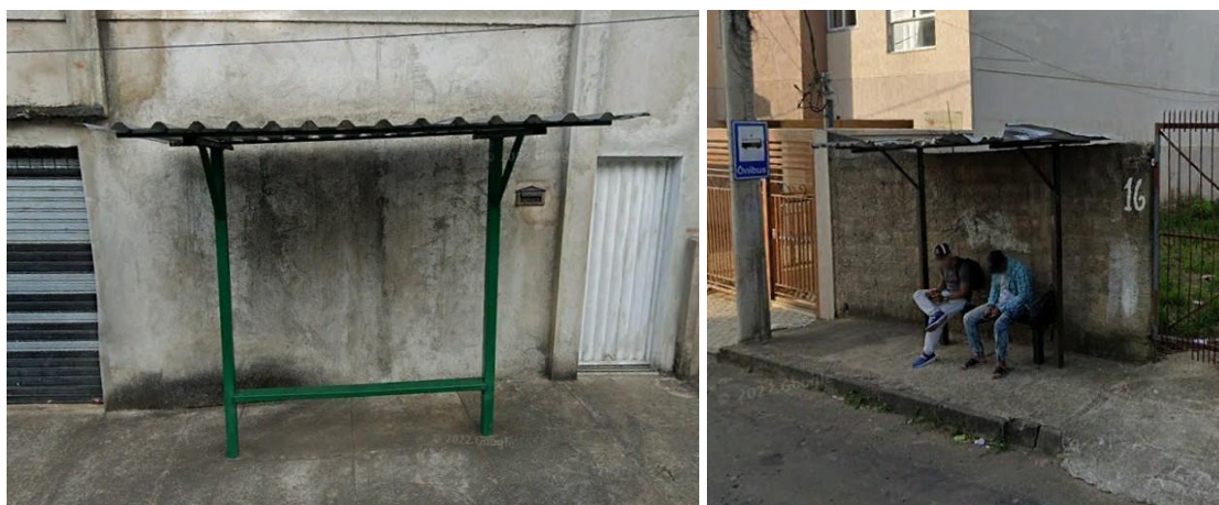
Figura 26 e Figura 27 - Pontos de ônibus com abrigo do bairro Nossa Senhora de Fátima
