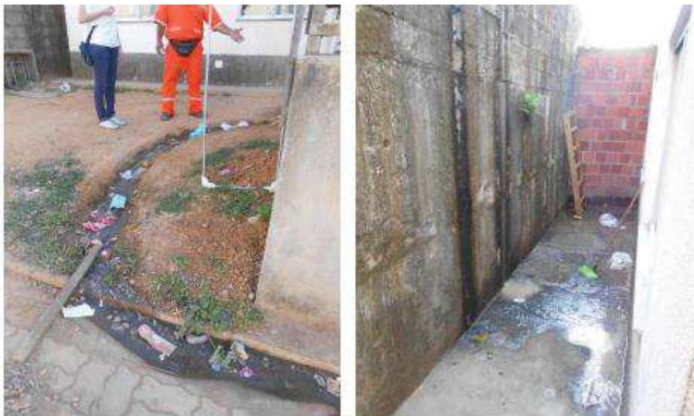
Figura 16 Vazamentos de esgoto.
