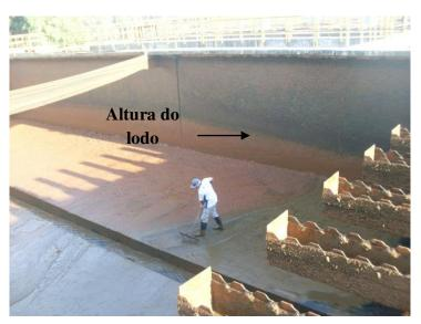
**Figura 4.6 -** Altura do lodo visível durante a raspagem manual de um decantador. Fonte: Arquivo Pessoal.
