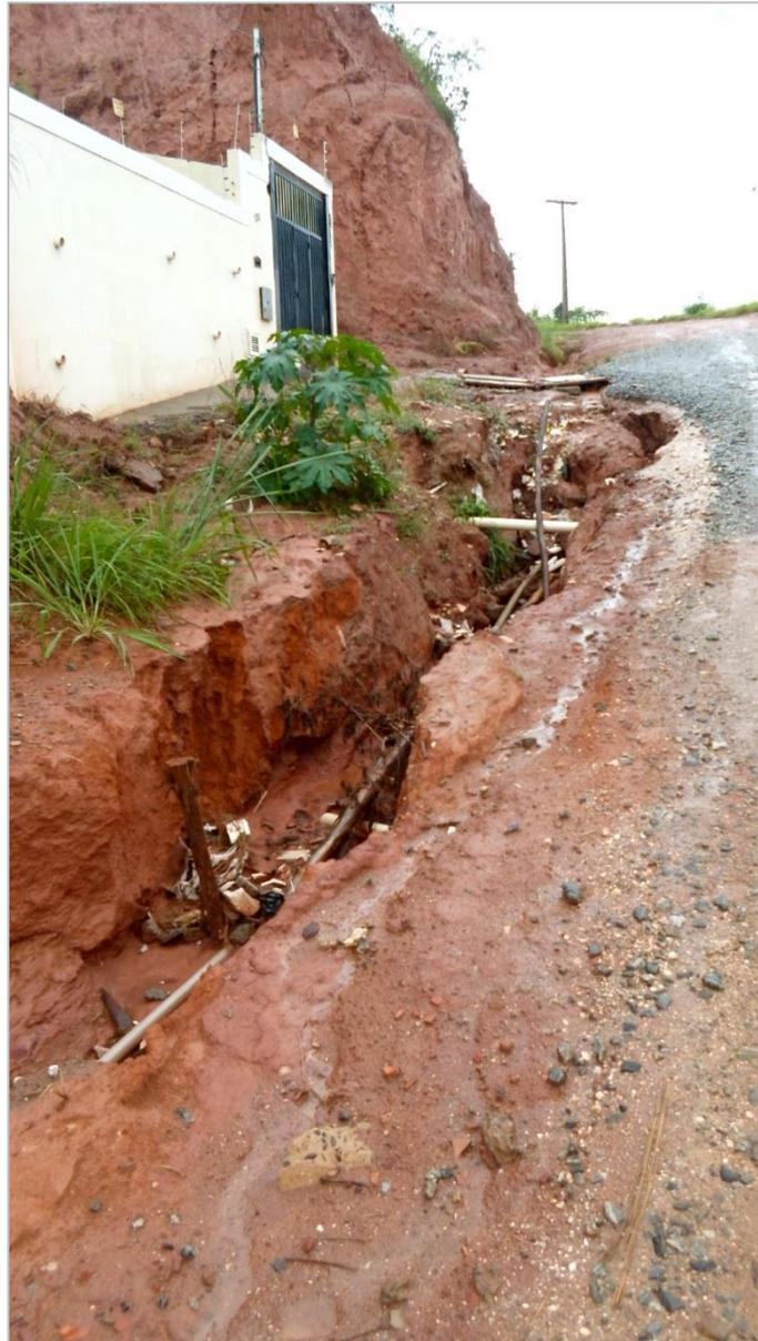
Figura 2.9 – Corte realizado na encosta para construção de residência no bairro Bom Pastor com sistema de drenagem ineficiente, causando erosão em sulco na área de forma acelerada.
