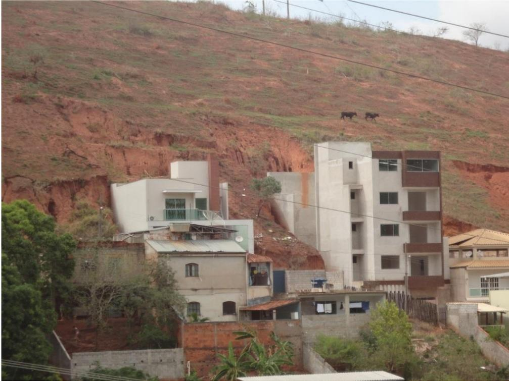
Figura 5.12 – Erosão laminar em uma encosta no bairro Eldorado, onde há corte em 90° para construção de residências, presença de sulcos no talude e, ainda, pisoteio de gado. Fotografia de Novembro de 2014. Fotografia do autor.
