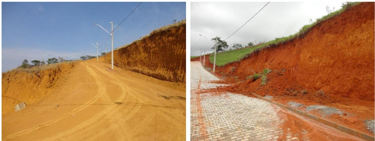
Figura 5.3 – Movimento de massa em encosta exposta à ação da chuva. Fotografia a esquerda de Outubro de 2014 e a direita Dezembro de 2015. Fotografias do autor.
