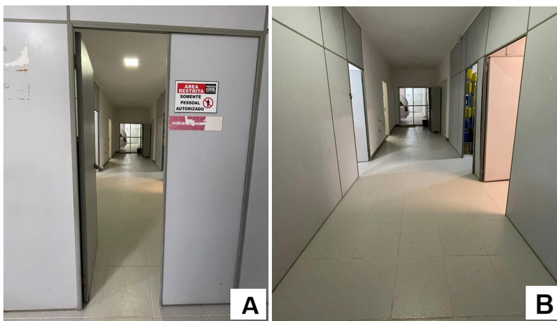
Figura 4 – Porta localizada na secretaria (A), que se abre para um corredor (B) e dá acesso às diferentes salas no PML de Governador Valadares.
