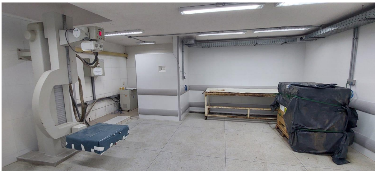
Figura 21 – Espaço para realização de Exame Radiográfico no IML-AR de Belo Horizonte, em que há um aparelho instalado para este fim.
