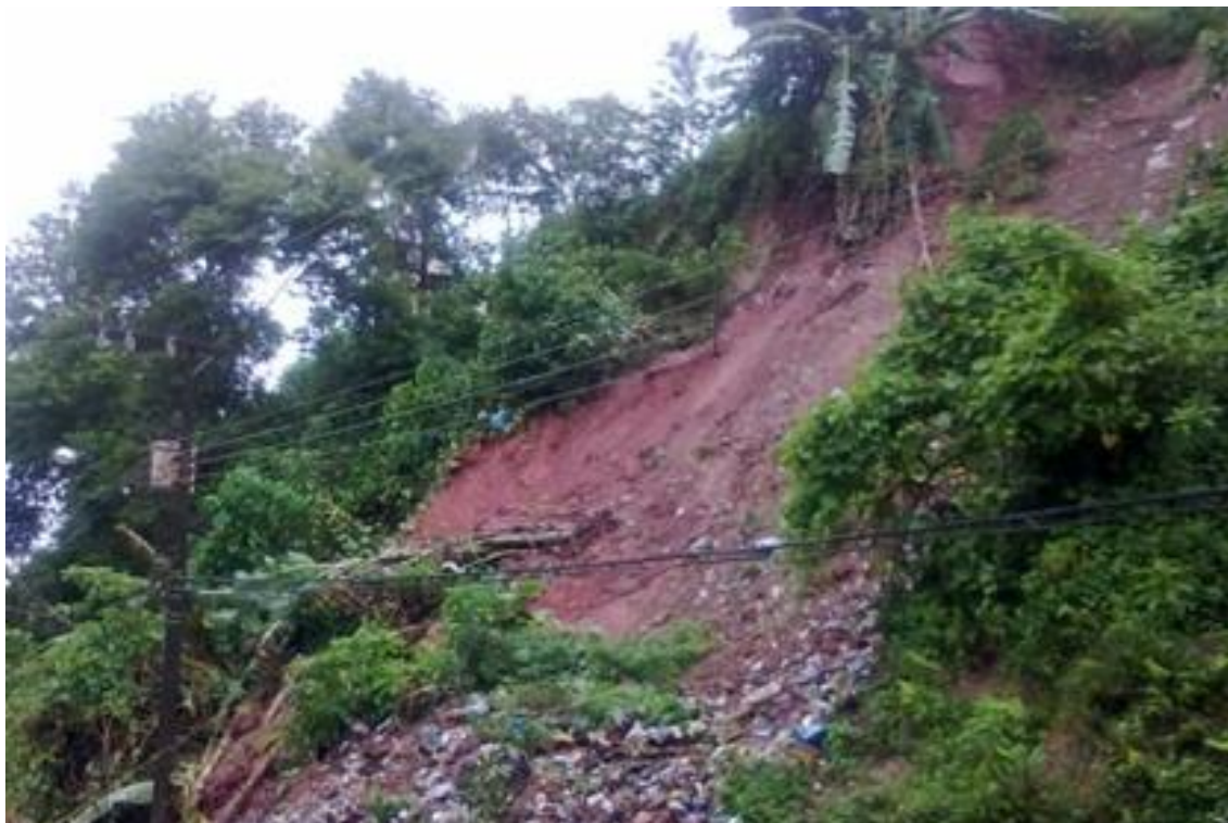
Figura 5. 1 Deslizamento no bairro Córrego do Ouro
