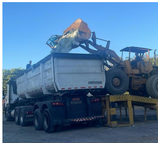
(h) Carregamento do material.
