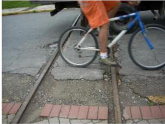
Figura 22. Passagem em más condições de tráfego para pedestres. Fonte: Zangerolamo, 2015.
