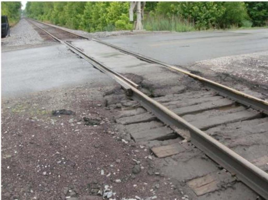
Figura 16. Cruzamento mal drenado. Fonte: Rose *et al.*, 2014.
