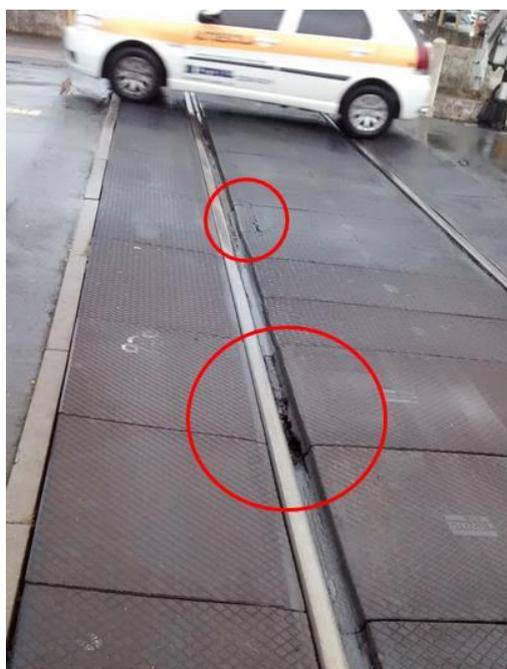
Figura 36. Rachaduras nas placas. Fonte: O autor.
