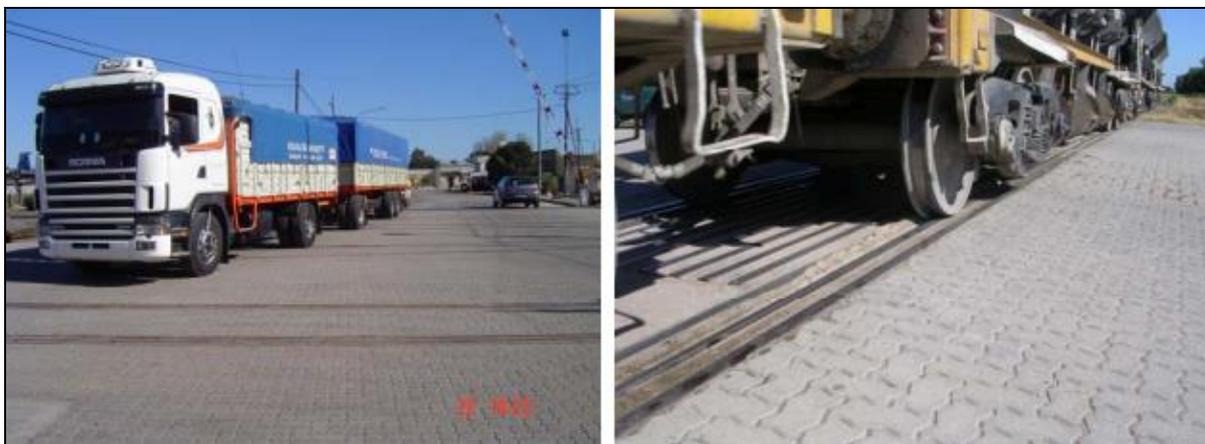
Figura 13. PN com revestimento em blocos de concreto. Fonte: Gordillo & Arena, 2009.
