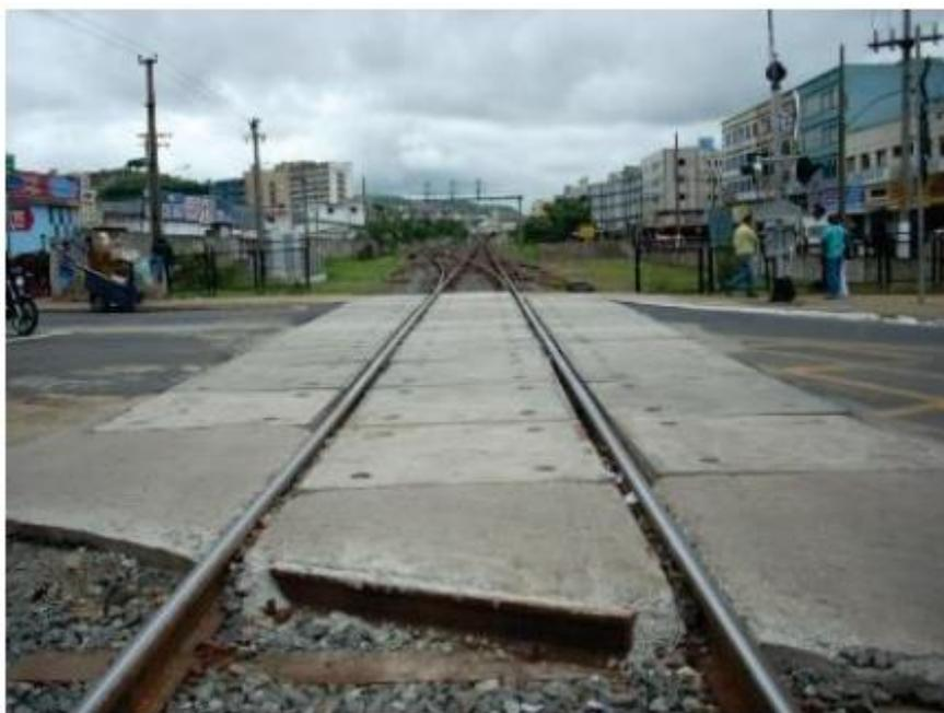
Figura 31. PN Benjamin Constant com placas de concreto pré-moldado. Fonte: Zangerolamo, 2015.
