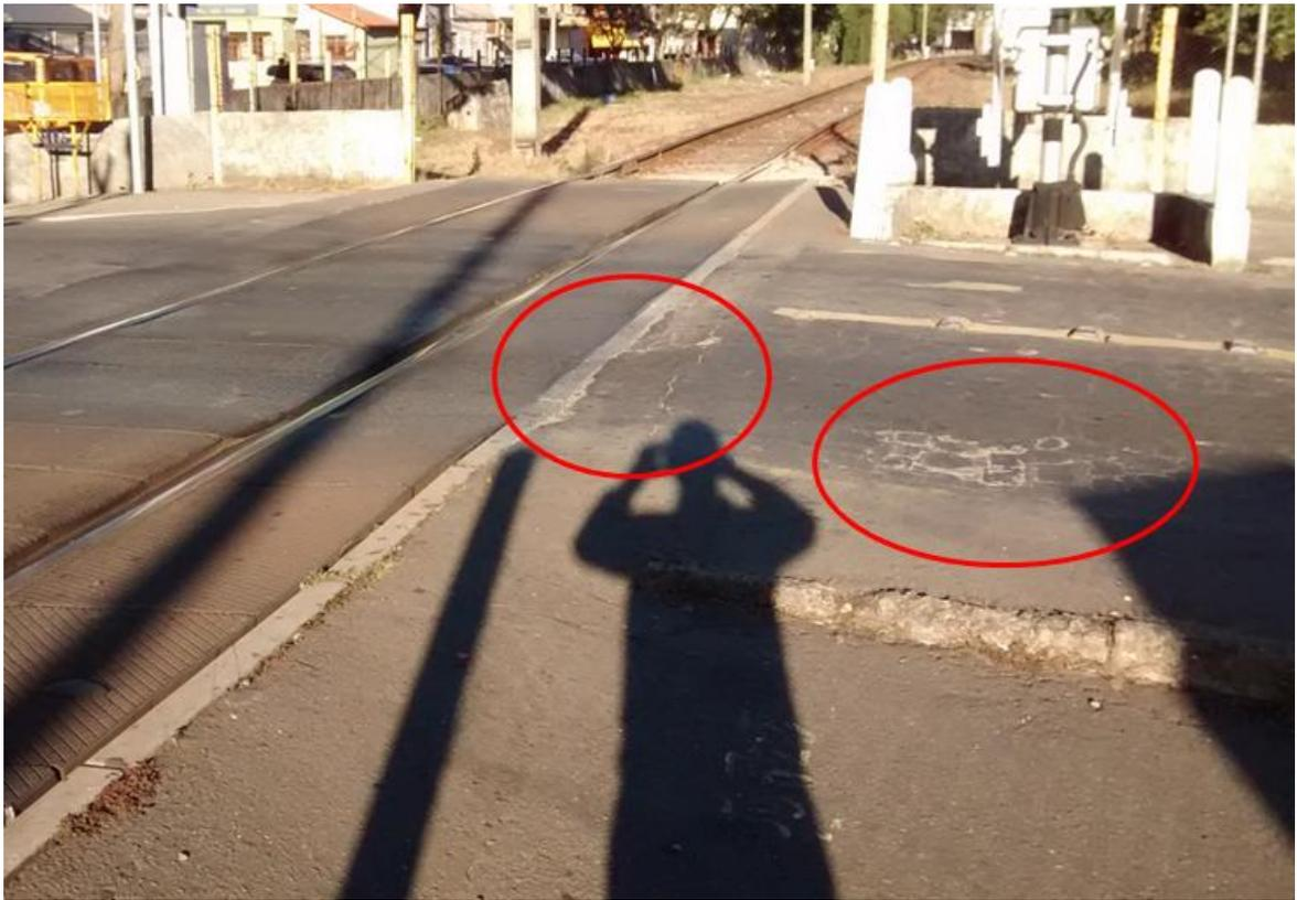
Figura 33. Deformação do asfalto próximo da superfície da PN. Fonte: O autor.
