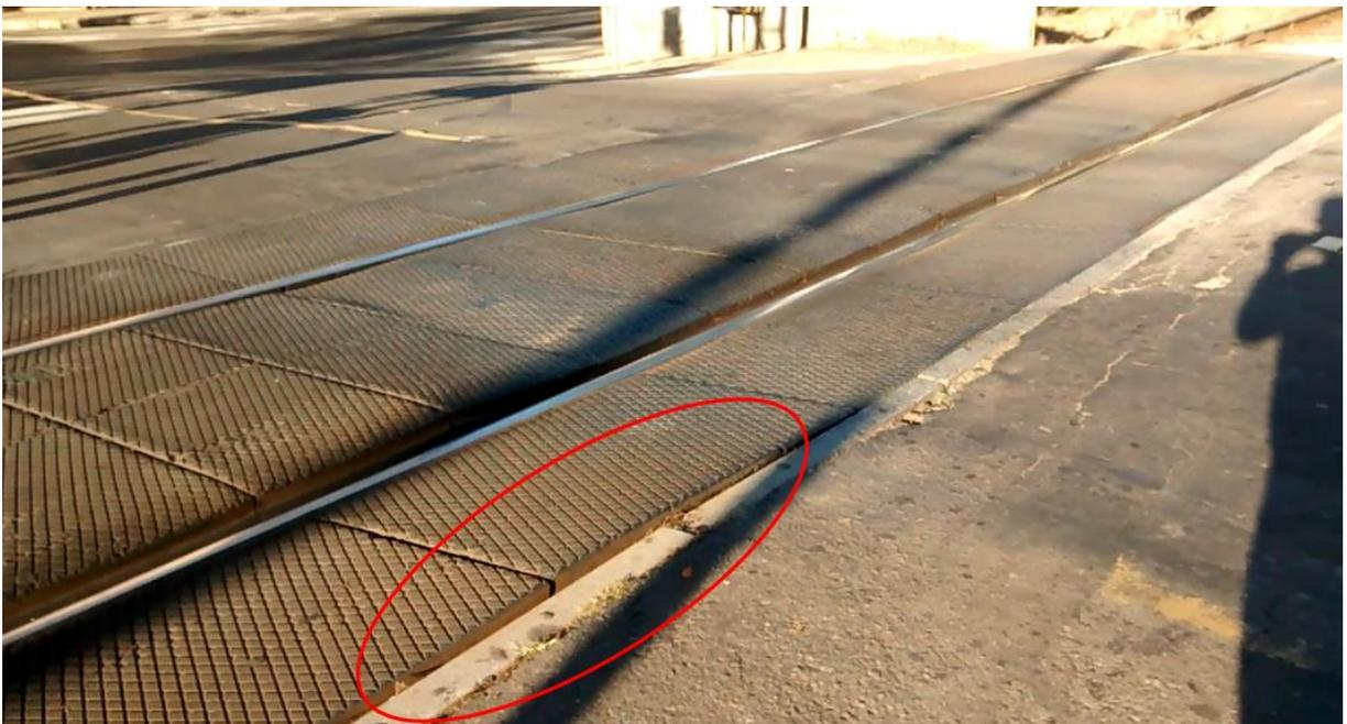
Figura 34. Movimentação das placas de borracha. Fonte: O autor.
