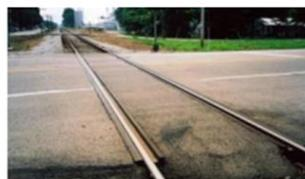
**Asfalto com acabamento de borracha**
