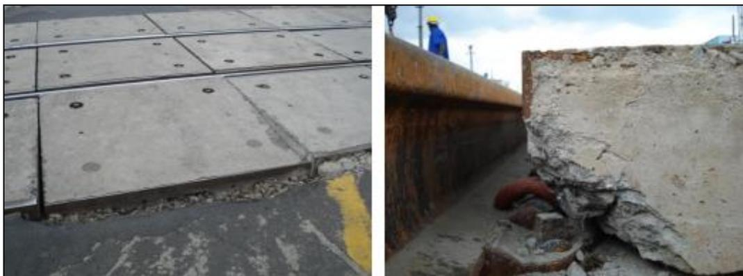
Figura 32. Movimentação e quebra das placas de concreto. Fonte: Carmo & Campos, 2009.
