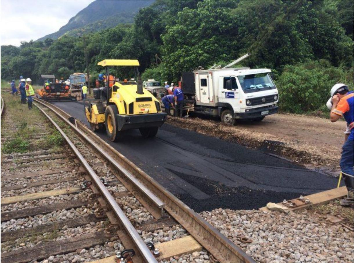
Figura 45. Primeira aplicação de sublastro asfáltico na malha ferroviária brasileira. Fonte: MRS, 2017.
