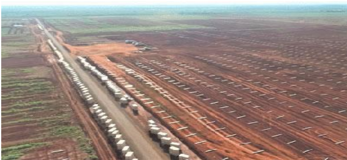
Figura 7 – Imagens da construção do Parque de Energia Fotovoltaica de Jaíba (MG)
