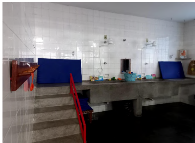
Figura 4 - Registro dos Lavatórios (dentro da sala, separado por um portão de madeira)
