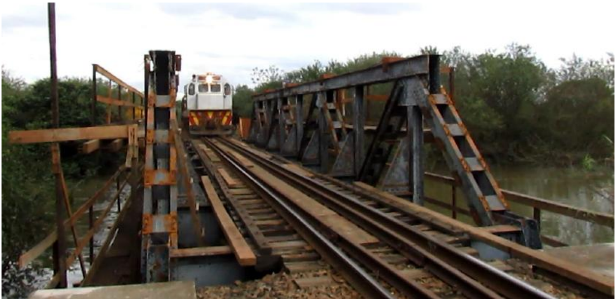
Figura 7 – Ponte em estudo
