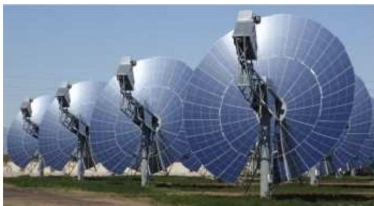
Figura 84 – Disco solar parabólico.
