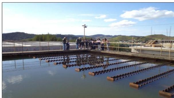
Figura 12 - Foto de tanques de decantação em uma estação de tratamento de água
