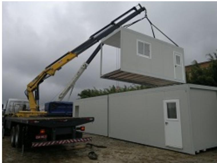
Figura 2.2: Exemplo de construção modular. Fonte: Modularis (2014).
