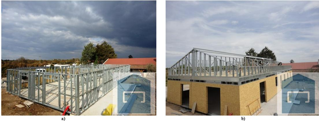
Figura 2.1: Exemplo de construção utilizando o sistema construtivo estruturado em perfis metálicos. a) Aspecto inicial da estrutura e b) Iniciando o fechamento externo. Fonte Futureng (2014).
