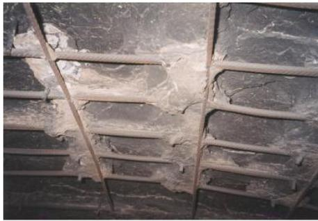
(b) Armadura exposta após incêndio no Chanel Tunnel, França - Inglaterra [13]
