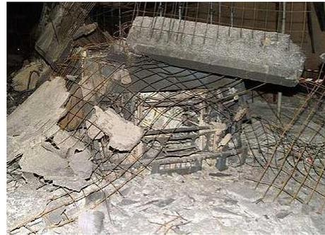
(c) Colapso estrutural do Gotthard Tunnel, Suíça [13]
