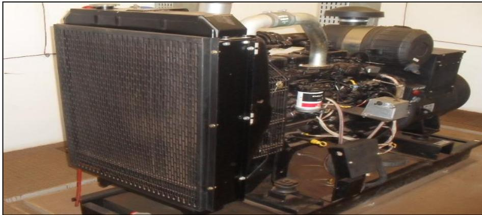
**Figura 2-20 - Grupo Motor Gerador de Emergência**
