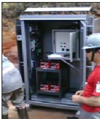
**Figura 2-26 - Caixa de locação para alimentação da chave motorizada**
