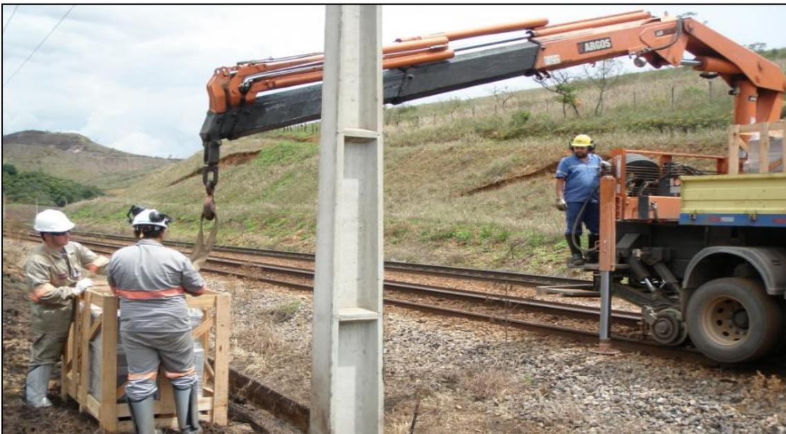
**Figura 4-57 - Descarregamento dos reatores em campo**
