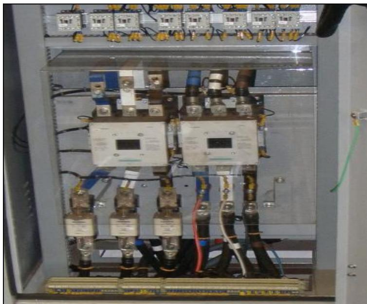
**Figura 2-15 - Contatores K2 e K1**
