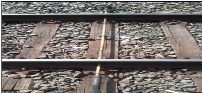
**Figura 2-7 - Detector de descarrilamento**
