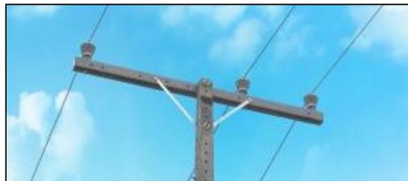
**Figura 2-23 - Alimentador de distribuição trifásico**
