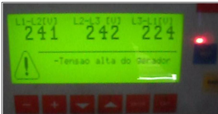
Figura 3-6 - USCA do GMG no P1-5- Informações após o *trip* por sobretensão
