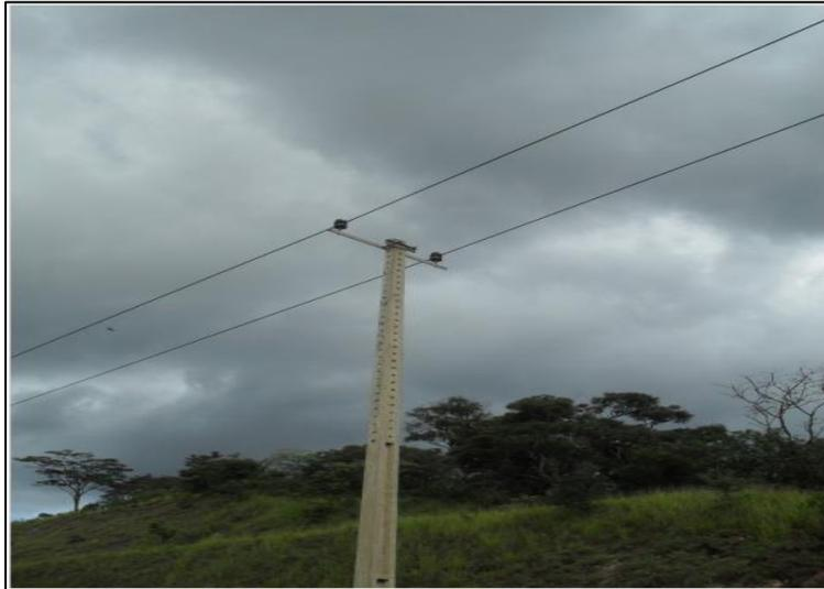
**Figura 2-22 - Alimentador de distribuição ferroviário bifásico**
