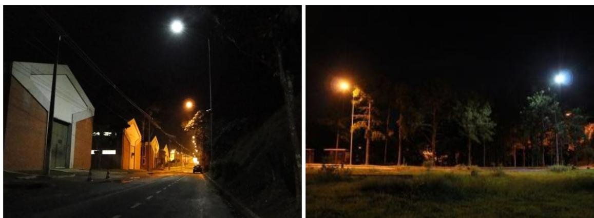
Figura 5.25: Fotos do anel viário da quarta plataforma da Universidade Federal de Juiz de Fora comparando a iluminação feita por uma luminária com lâmpada de vapor de sódio com uma luminária LED.
