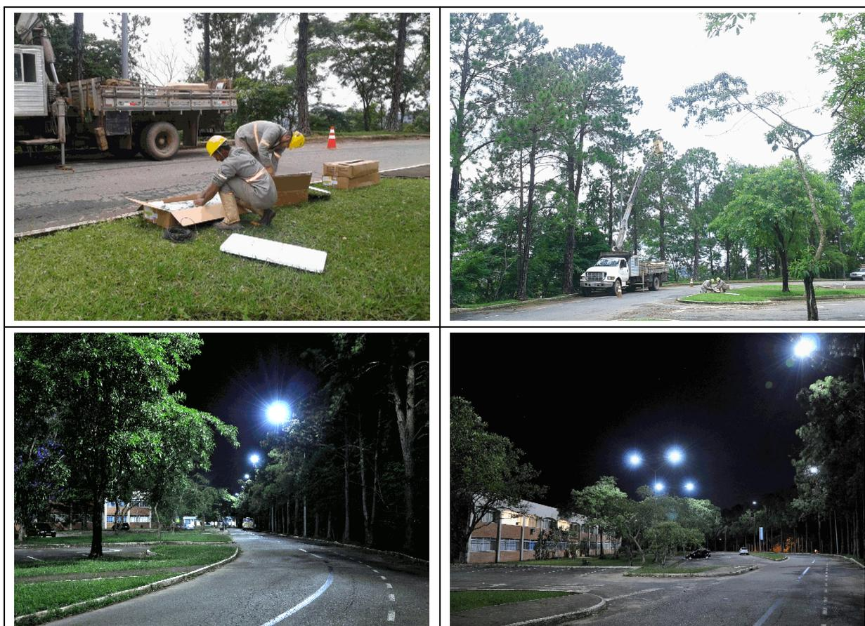
Figura 5.10: Processo de Instalação das Luminárias LED e os resultados obtidos.
