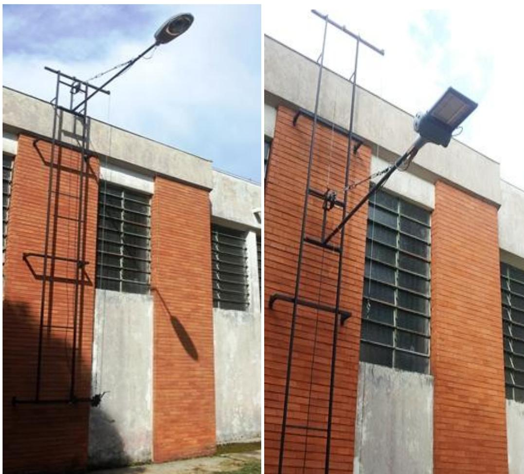
Figura 3.19: Estrutura de fixação de luminárias.
