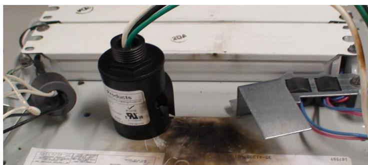
Figura 5.20: Varistor queimado de uma luminária que parou de funcionar após tempestade.
