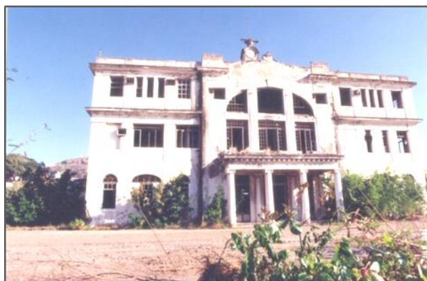
Figura 30: Estação Pedro Nolasco abandonada
