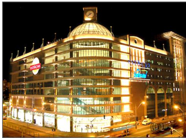
Figura 17: Shopping Estação Fonte: http://rs-engenharia.com.br/obra/shopping-estação/
