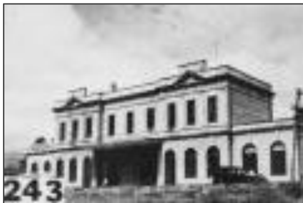
Figura 40: Segunda edificação da EFL, no centro da cidade. Fonte: http://www.estacoesferroviarias.com.br/efl_ramais_1/juizfora-efl.htm
