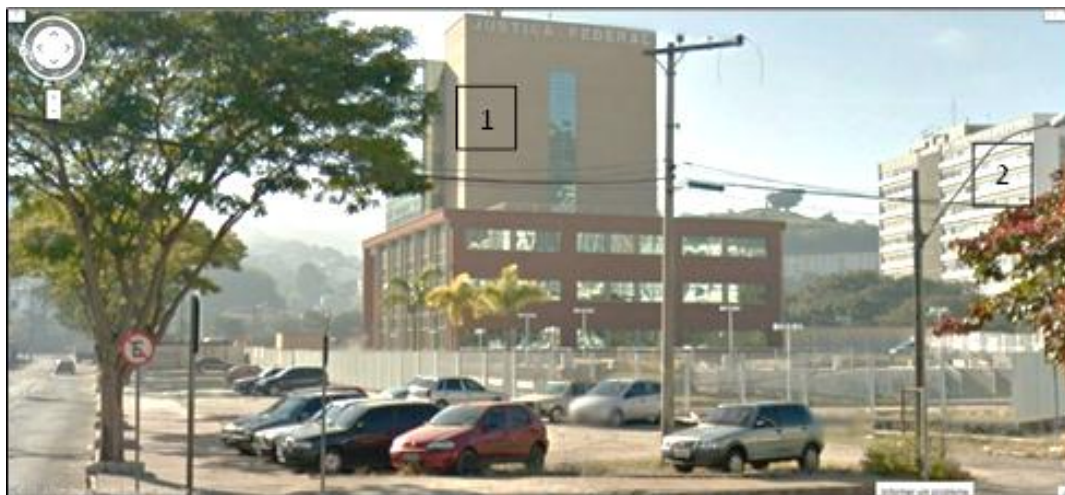
1 – prédio da Justiça Federal 2 – prédio sede da PJC
