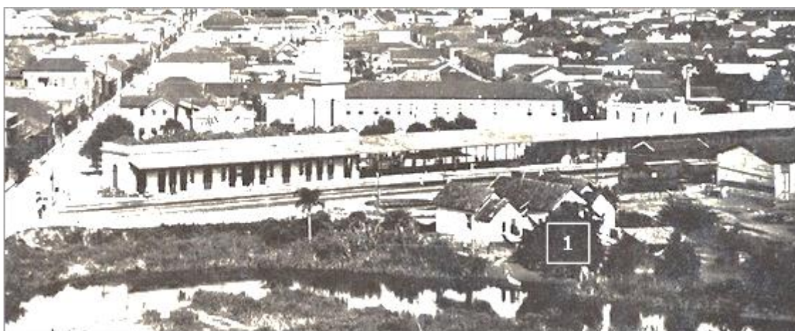
(58a): 1 – núcleo inicial da futura Avenida Raul Soares
