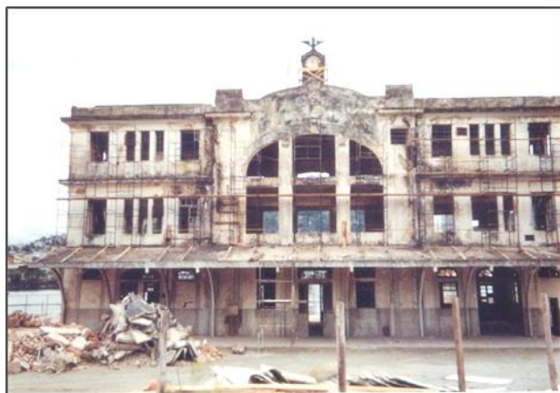
Figura 31: Estação Pedro Nolasco em reforma
