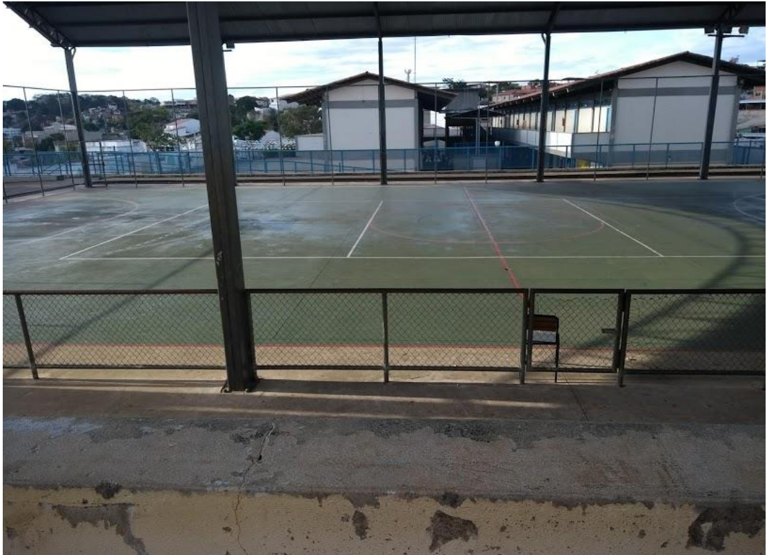
FIGURA: Vista da parte de trás da quadra.
