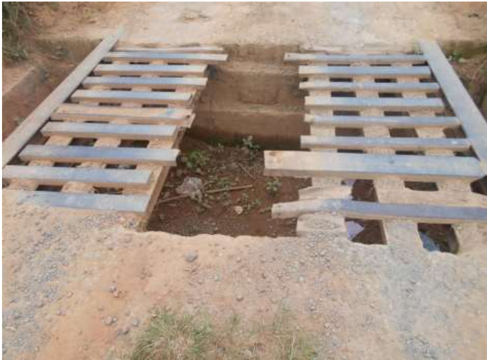
Figura 5 - Mata-burro localizado na estrada da Colônia
