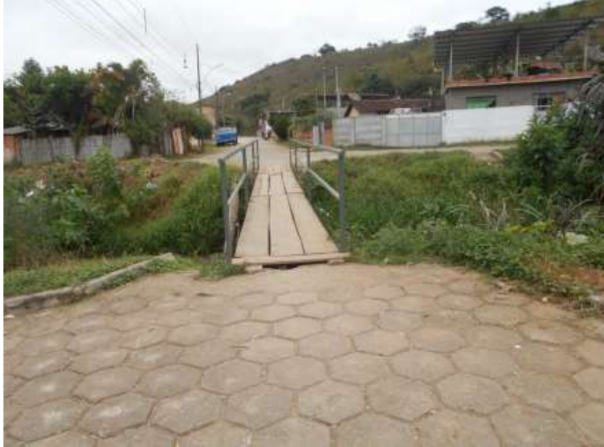
Figura 4 - Ponte está localizada entre a Rua G e a Avenida Nossa Senhora da Conceição
