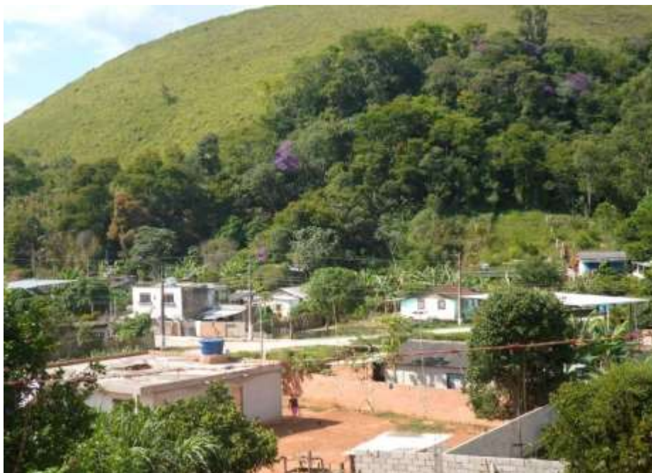
Figura 2 - Entrada da Colônia pela estrada de Chapéu D’Uvas
