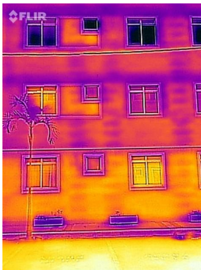
Bloco C, fachada lateral direita
