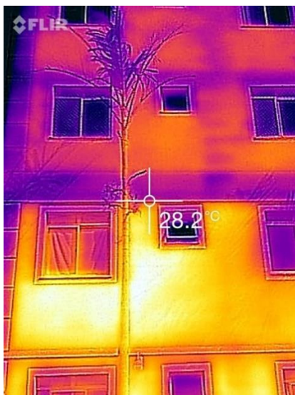
Bloco G, fachada lateral direita
