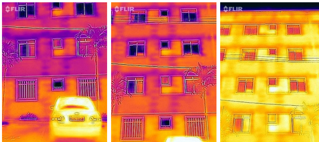
a) Termograma a 0^\circ
