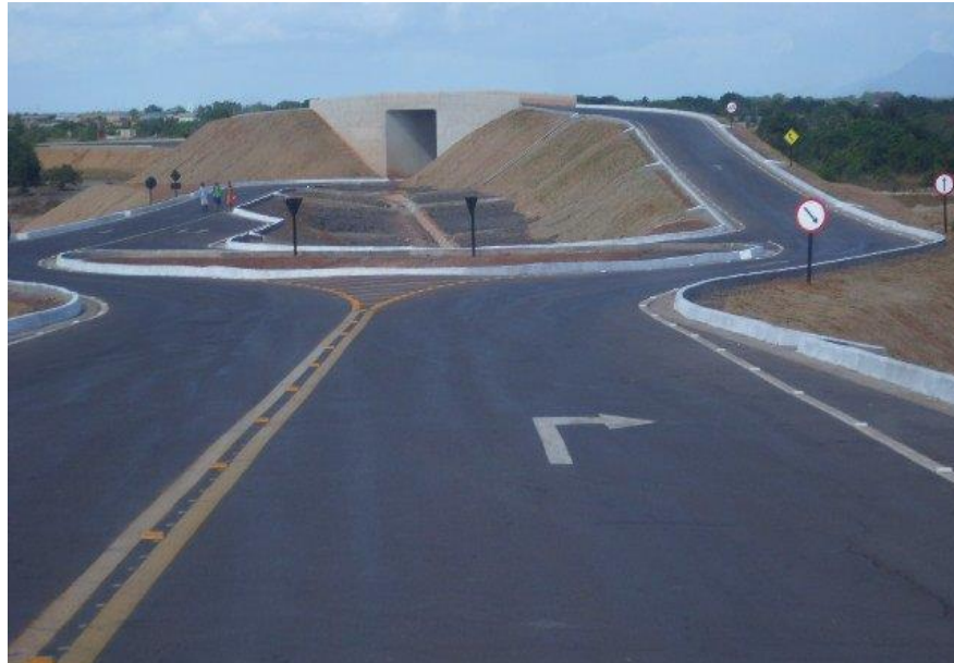
Foto 04 – Viaduto de conversão para a mão inglesa após a inauguração da ponte
