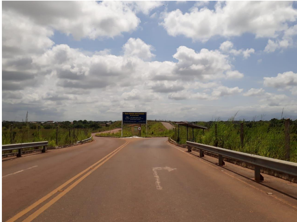
Foto 05 – Viaduto de conversão para a mão inglesa
