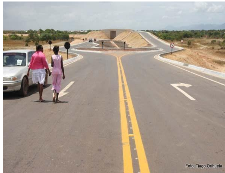
Foto 06 – Travessia de pessoas sobre a ponte Brasil-Guiana
