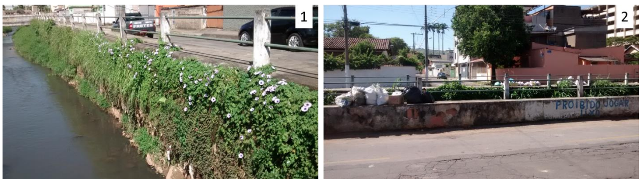
Figura 33: 1. Detalhe das flores Ipomoeas ( Ipomoea cairica ) nas paredes em gabião do canal do córrego Humaitá; 2. Imagem da estreita calçada ao longo do córrego Humaitá, com aproximadamente noventa centímetros de altura. Detalhe no aviso escrito: “Proibido jogar lixo” próximo à três pontos com sacolas de lixo acumuladas
