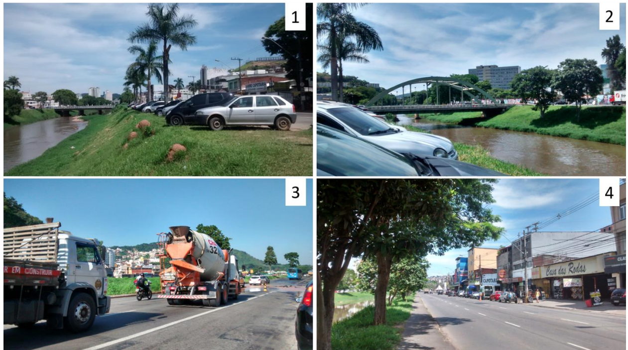
Figura 18: Prevalência de veículos na paisagem fluvial de Juiz de Fora. 1 e 2. Veículos estacionados em trecho de alargamento das margens do rio Paraibuna; 3. Fluxo de veículos no binário da Avenida Brasil; 4. Comércio predominantemente voltado para atender ao setor de automóveis.
