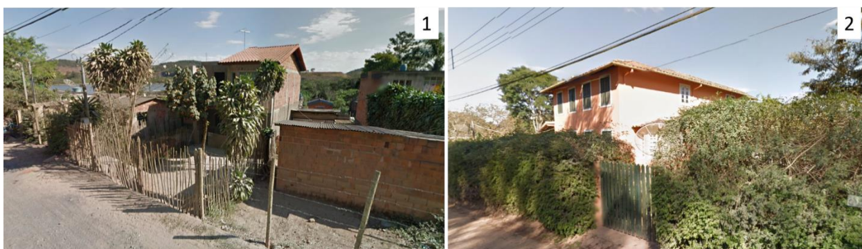
Figura 38: 1 e 2. Edificações que contornam a represa de São Pedro com diferentes padrões de qualidade
