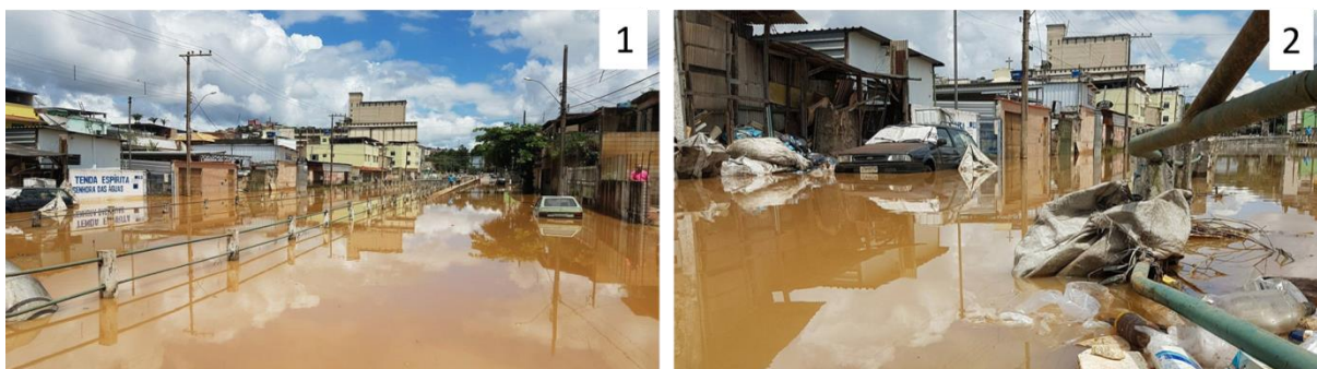
Figura 30: Cheias do córrego Humaitá e do rio Paraibuna impactam o bairro industrial em 11 de março de 2018
