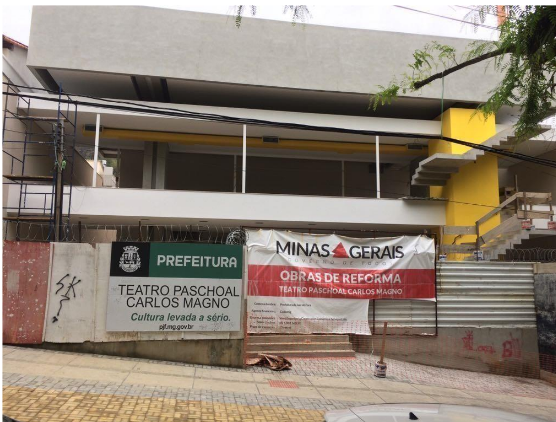
Figura 13 – Fachada do Teatro Paschoal Carlos Magno, no centro de Juiz de Fora, em fase de acabamento (Foto: Marina Metri)
