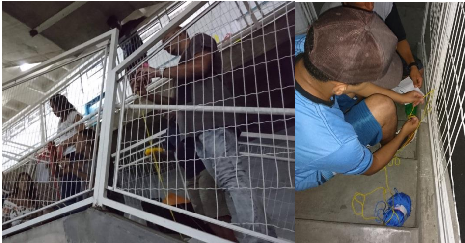
Fig. 05 e 06 - Intervenção nas grades da escada Fonte: Arquivo pessoal
