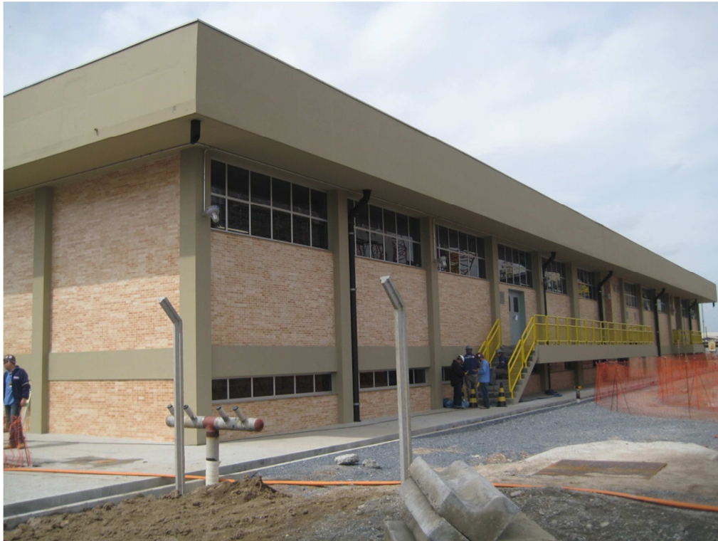
Figura 3 – Subestação de Unidade – Vista externa - Refinaria de Petróleo.
