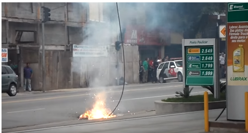
Figura 1: Exemplo de falta de alta impedância.
