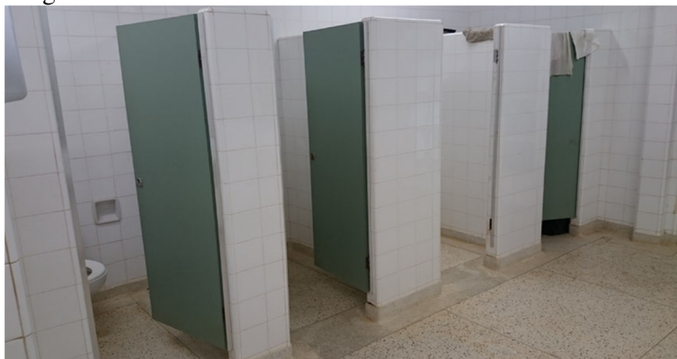
Figura 70 – Vista das cabines do sanitário feminino do térreo.
