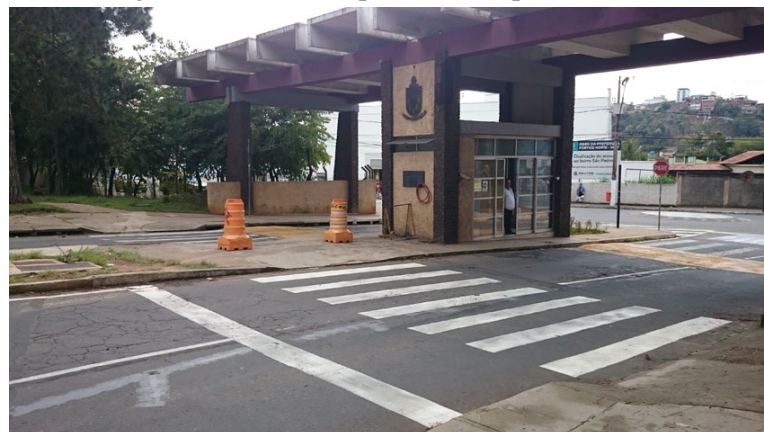
Figura 28 – Faixa de pedestres do pórtico norte.
