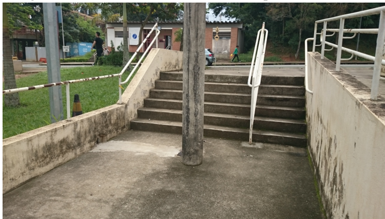
Figura 57 – Poste localizado no meio do patamar da escada.
