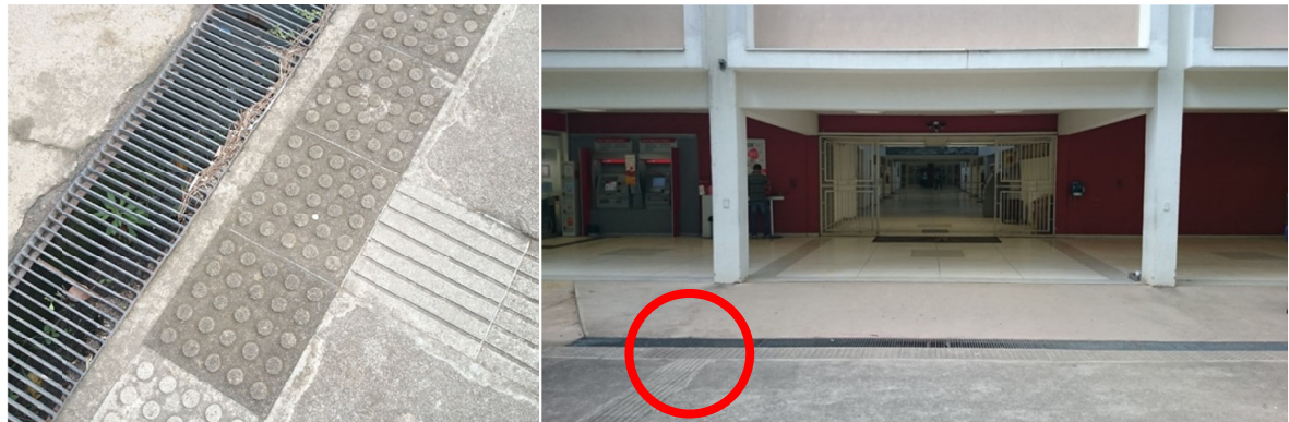
Figura 42 – Vista do acesso principal (B), piso podotátil na mesma cor do piso cimentado e grelha (A).
