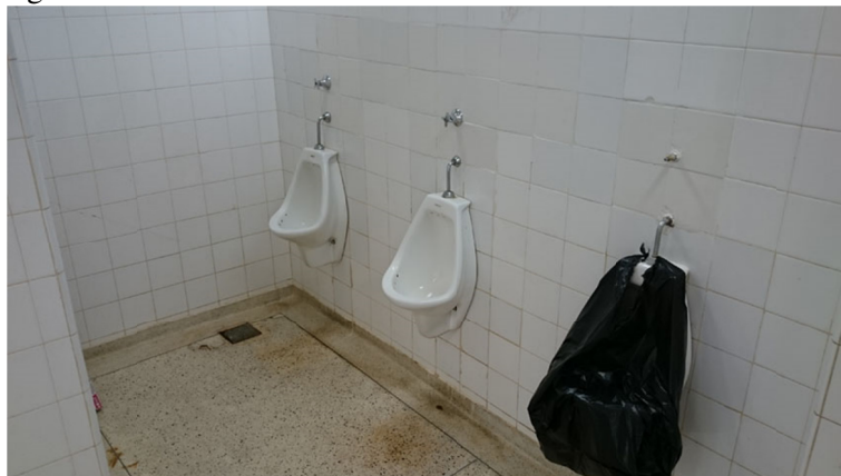
Figura 69 – Vista dos mictórios do sanitário masculino do térreo.
