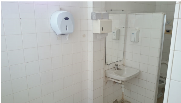
Figura 79 – Lavatório e acessórios do sanitário masculino próximo ao auditório.
