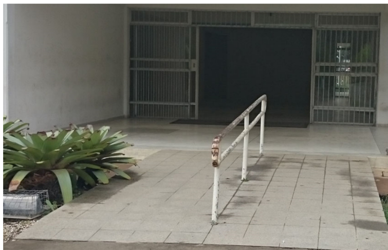
Figura 61 – Rampa de acesso à entrada secundária próxima ao Jardim Sensorial.
