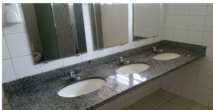
Figura 82 – Vista da bancada com as pias do sanitário feminino no corredor esquerdo das Pró-Reitorias.
