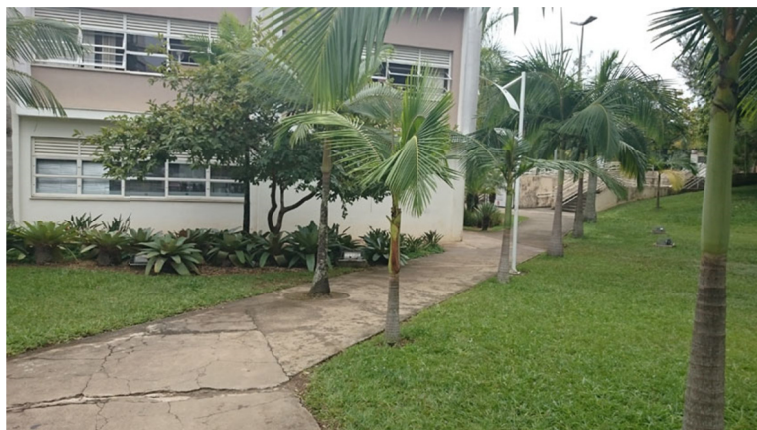
Figura 41 – Vegetação obstruindo a passagem na passarela de pedestres da via de veículos ao acesso principal.
