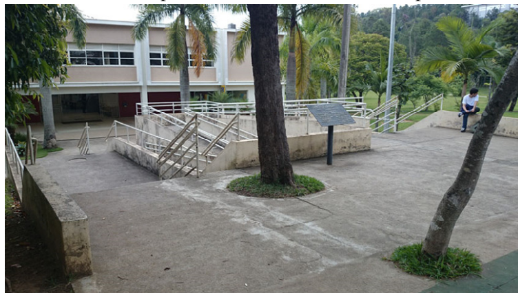
Figura 56 – Escadas e rampa de acesso à Reitoria vistas a partir do anel viário.
