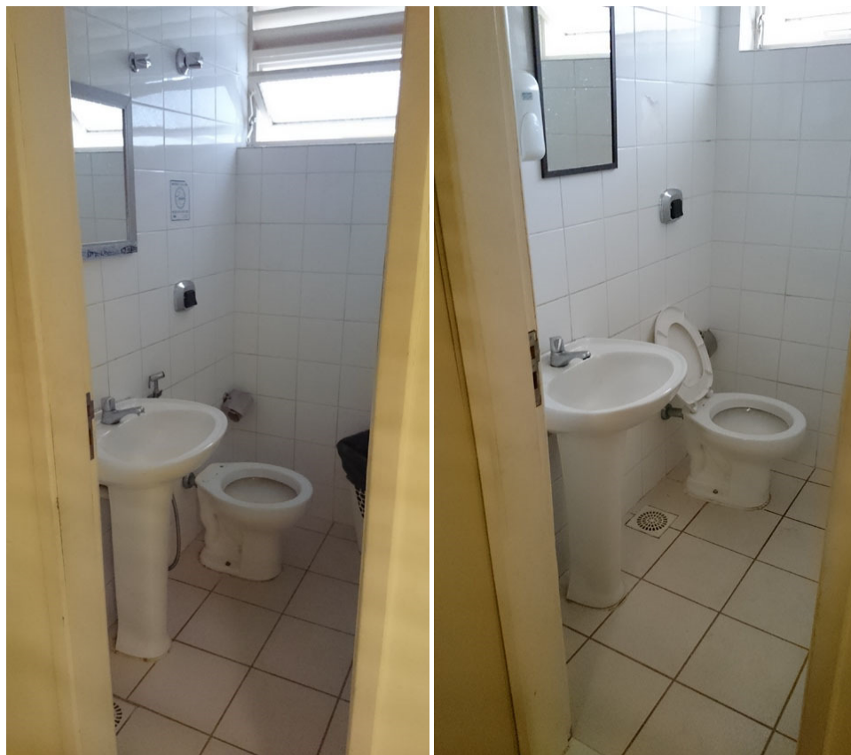
Figura 80 – Interiores dos sanitários feminino (A) e masculino (B), no segundo pavimento. (A) (B)
