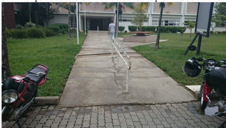
Figura 62 – Rampa de acesso à entrada secundária próxima ao estacionamento.
