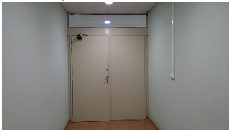
Figura 87 – Porta dupla de acesso ao corredor direito das Pró-Reitorias.
