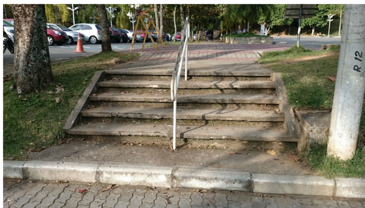
Figura 59 – Escada entre os estacionamentos 2 e 3 e a via de veículos.
