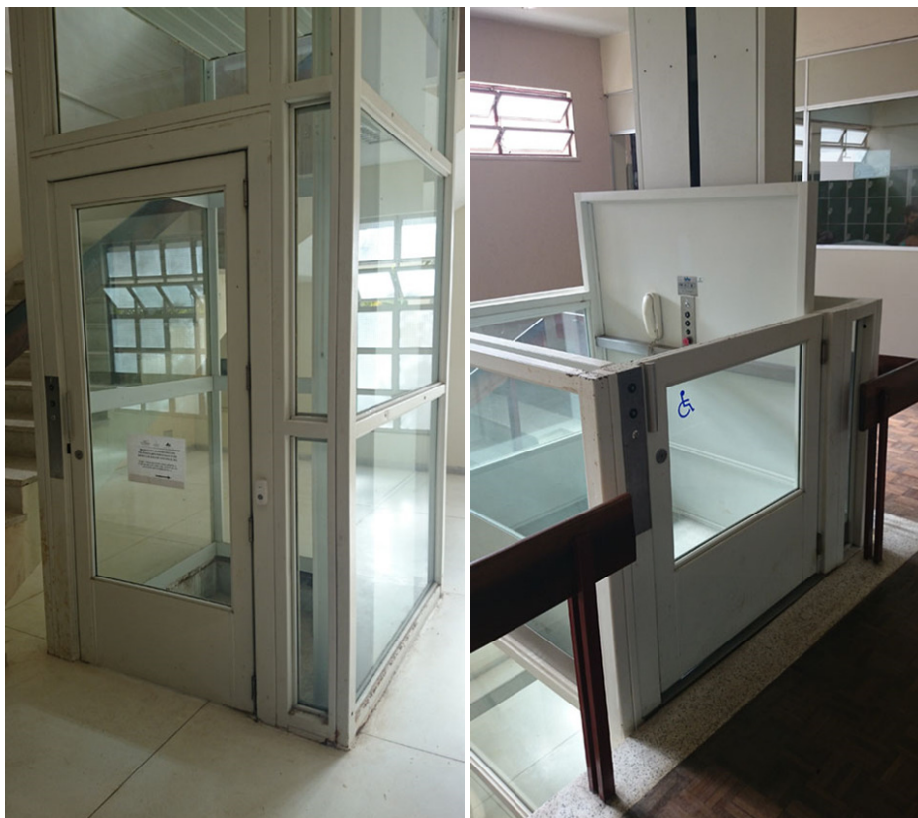
Figura 67 – Plataforma de percurso vertical no pavimento térreo (A) e no segundo pavimento (B).
