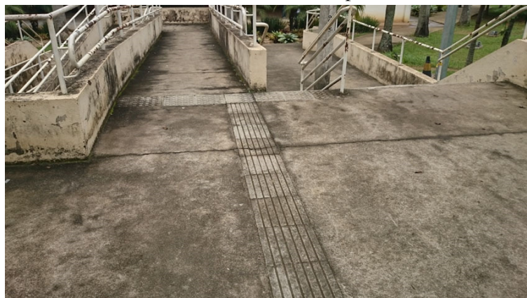
Figura 31 – Piso podotátil na mesma cor do piso cimentado, indo da calçada do anel viário até o início das escadas e da rampa.
