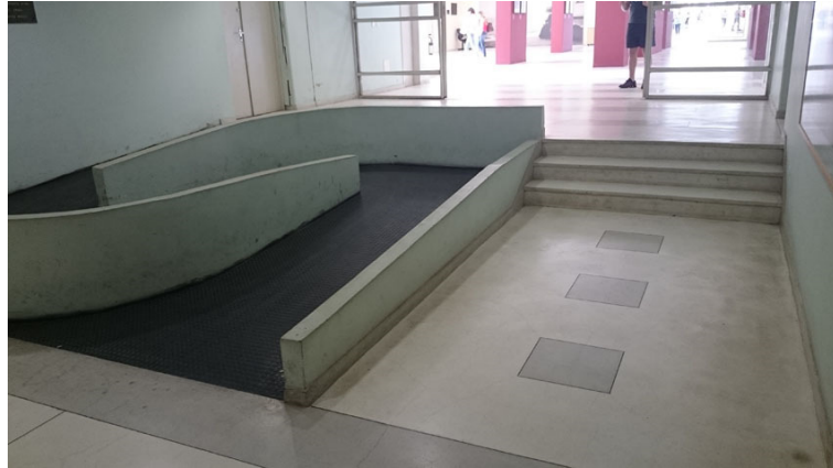
Figura 64 – Escada e rampa de acesso aos corredores das Pró-Reitorias.
