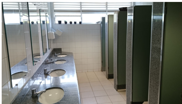
Figura 83 – Vista do sanitário feminino de funcionários próximo ao de pessoas com deficiência.
