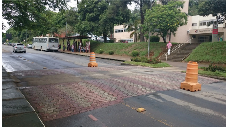
Figura 29 – Faixa de pedestres elevada com piso direcional.
