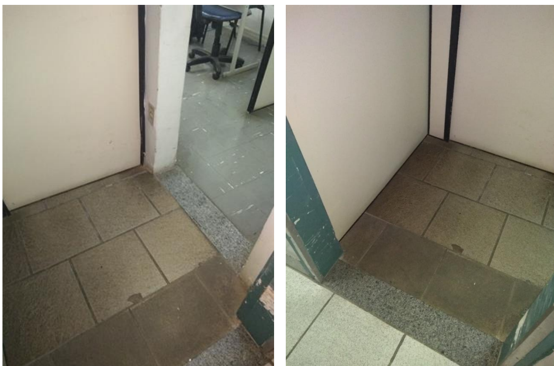
Figura 118 – Revestimento de uma das Clínicas
