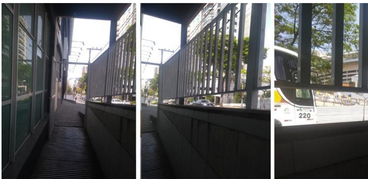
Figura 49 – Rua de fundos da Clínica 2
