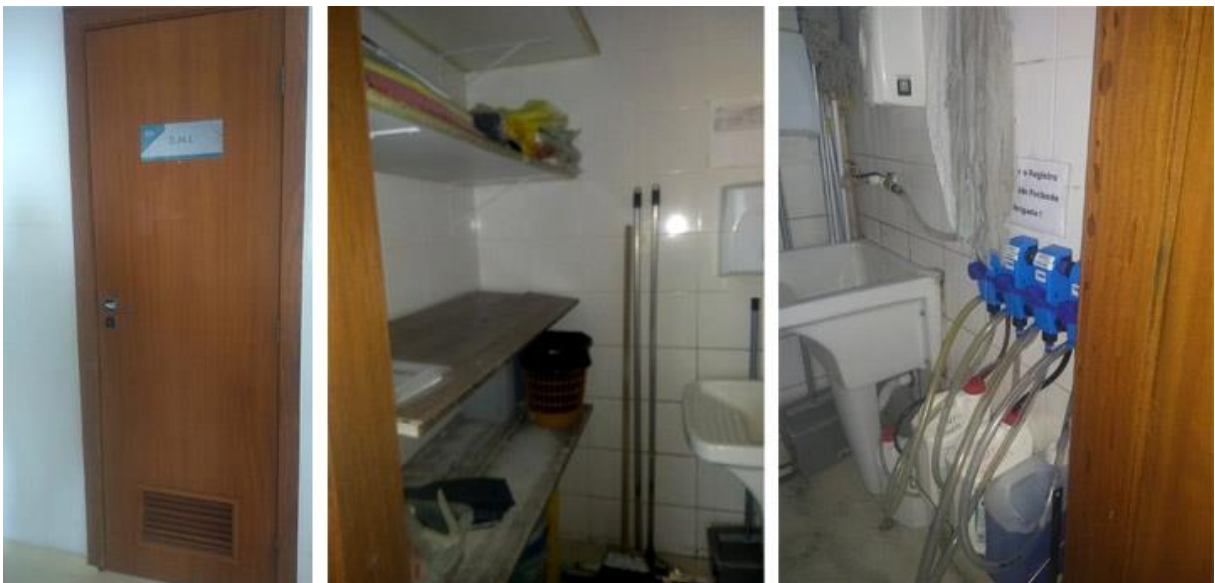
Figura 64 – Depósito de Material de Limpeza (DML)
