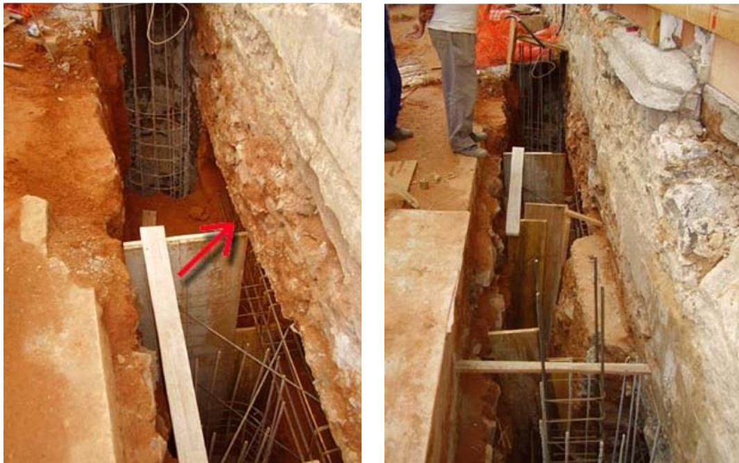
Figura 93 e figura 94: Construção de nova estrutura para fortalecer a fundação do Prédio Mariano Procópio.
