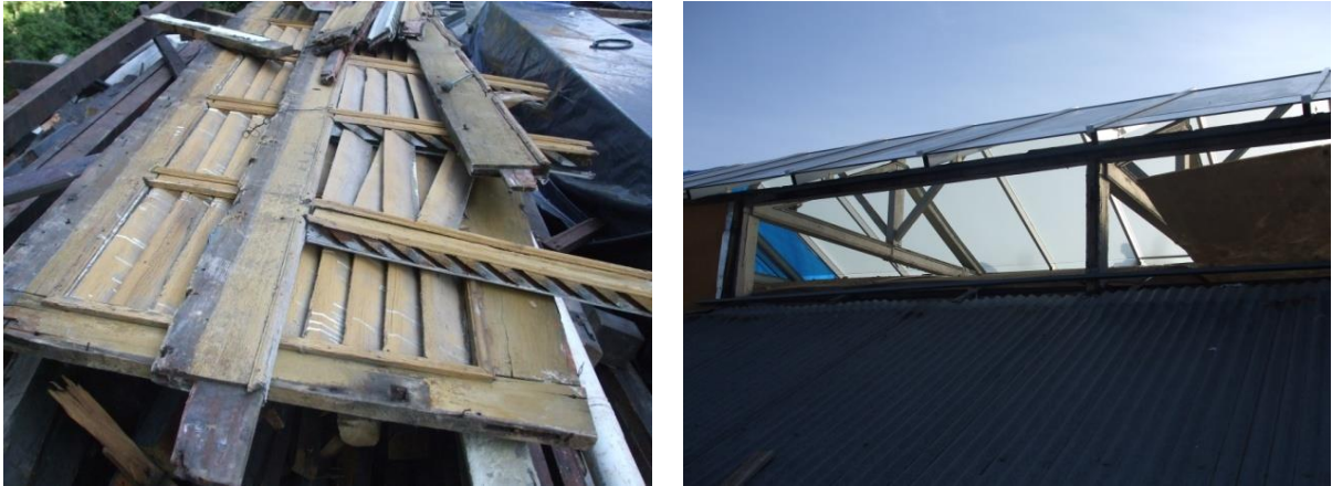
Figura 100 e figura 101: Retirada das venezianas metálicas que constituem a lateral do lanternim.
