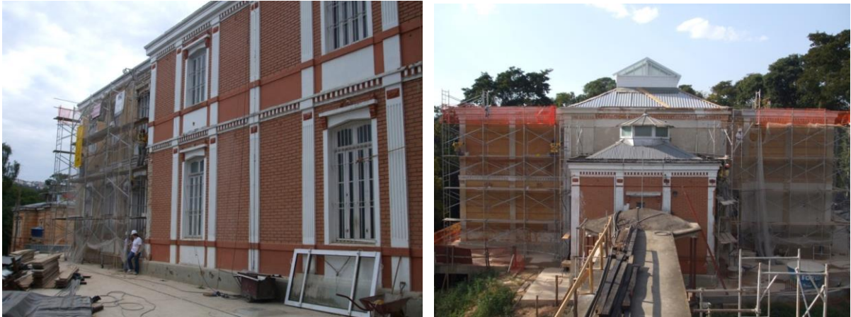
Figura 79 e figura 80: Retirada da cerâmica na fachada lateral esquerda e posterior.
