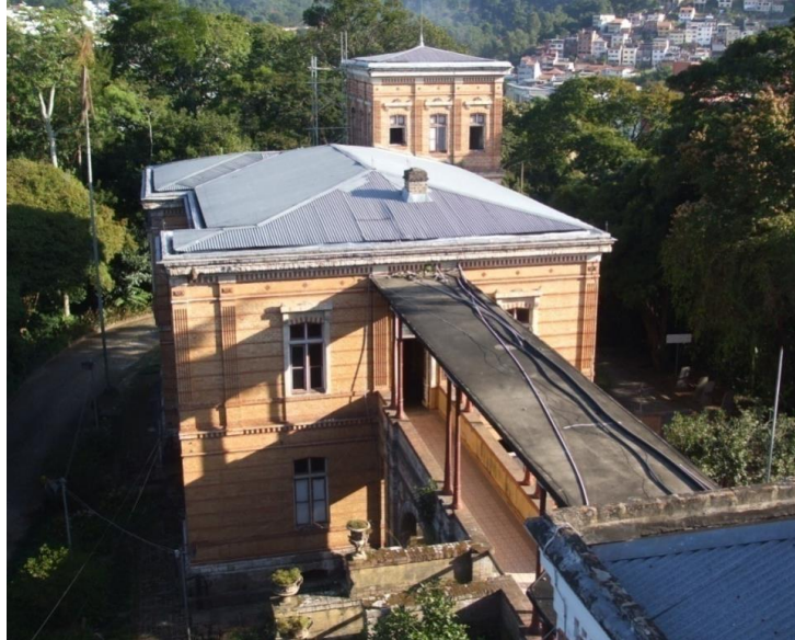
Figura 68: Telha de aço zincado da Villa Ferreira Lage .
