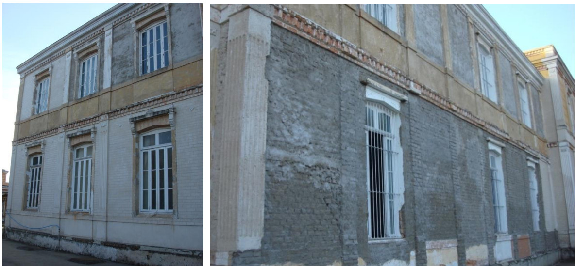
Figura 84 e figura 85: Fachada lateral esquerda não concluída.
