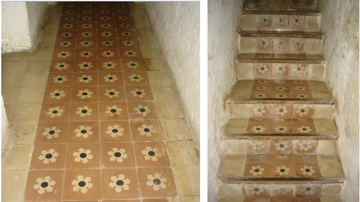
Figura 43 e figura 44: Ladrilho hidráulico na circulação e na escada do subsolo.
