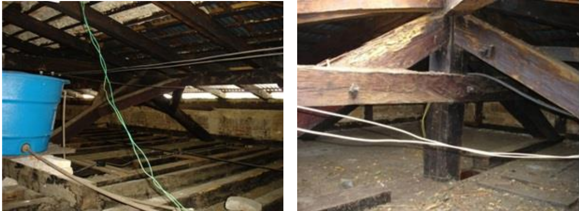
Figura 69 e figura 70: Estrutura do telhado antes da última reforma.
