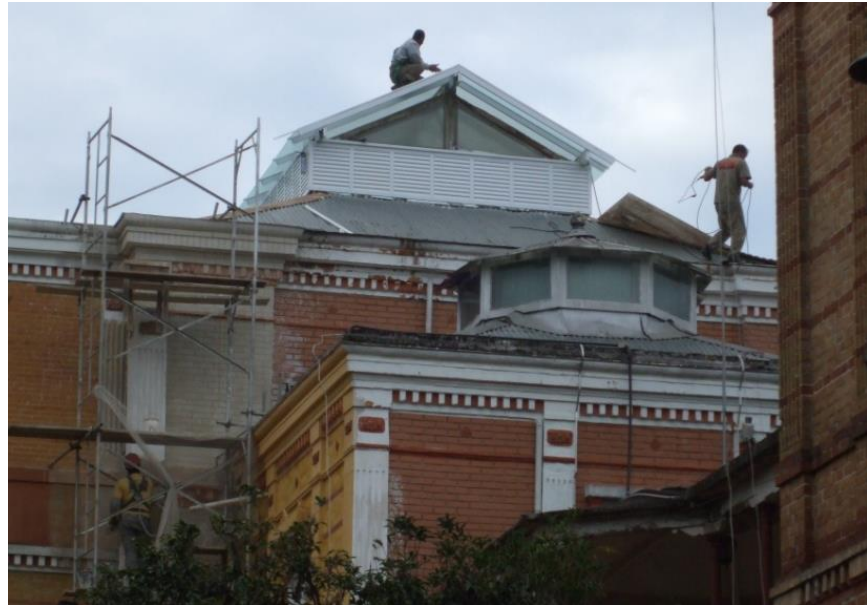
Figura 102: Instalação dos vidros a cobertura do lanternim.
