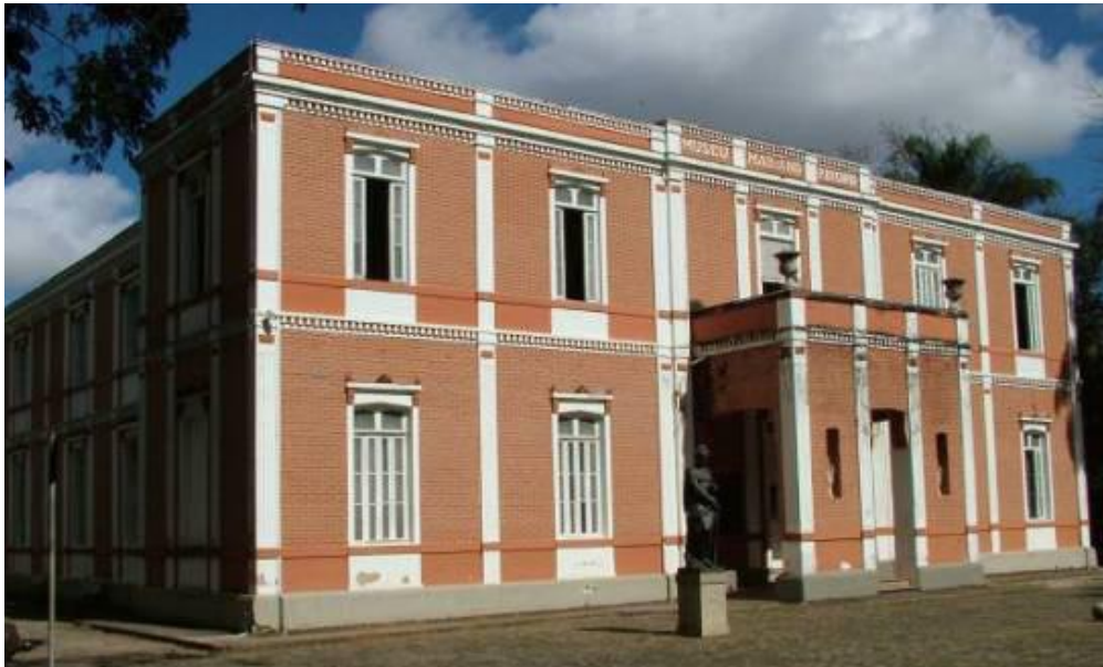
Figura 78: Revestimento cerâmico nas fachadas do Prédio Mariano Procópio.
