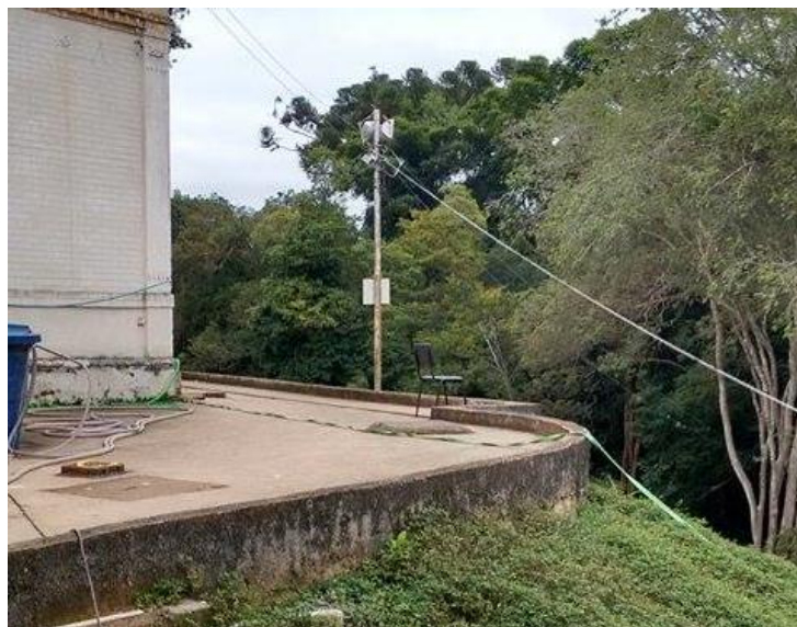
Figura 95: Estrutura construída para fortalecer a fundação do Prédio Mariano Procópio.
