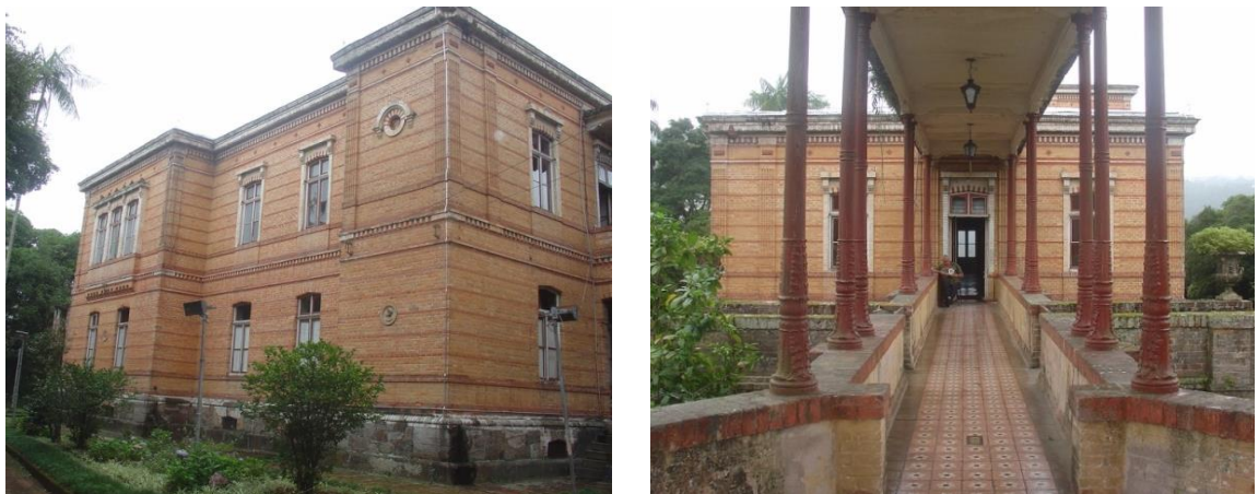
Figura 29 e figura 30: Fachada Lateral Esquerda e fachada posterior da Villa Ferreira Lage .
