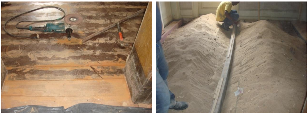
Figura 106 e figura 107: Restauração do piso de madeira.
