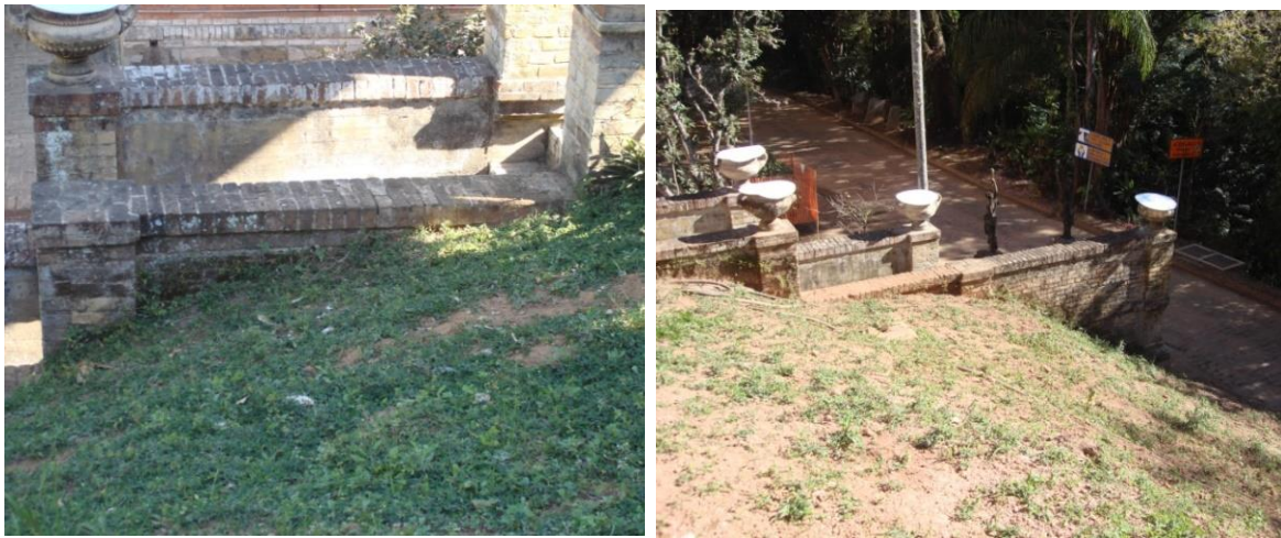
Figura 96 e figura 97: Terra movida em direção às paredes do passadiço.
