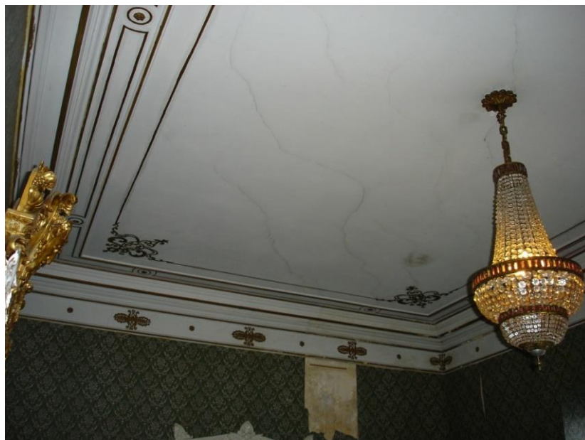
Figura 54: Forro da sala de costura no segundo pavimento.
