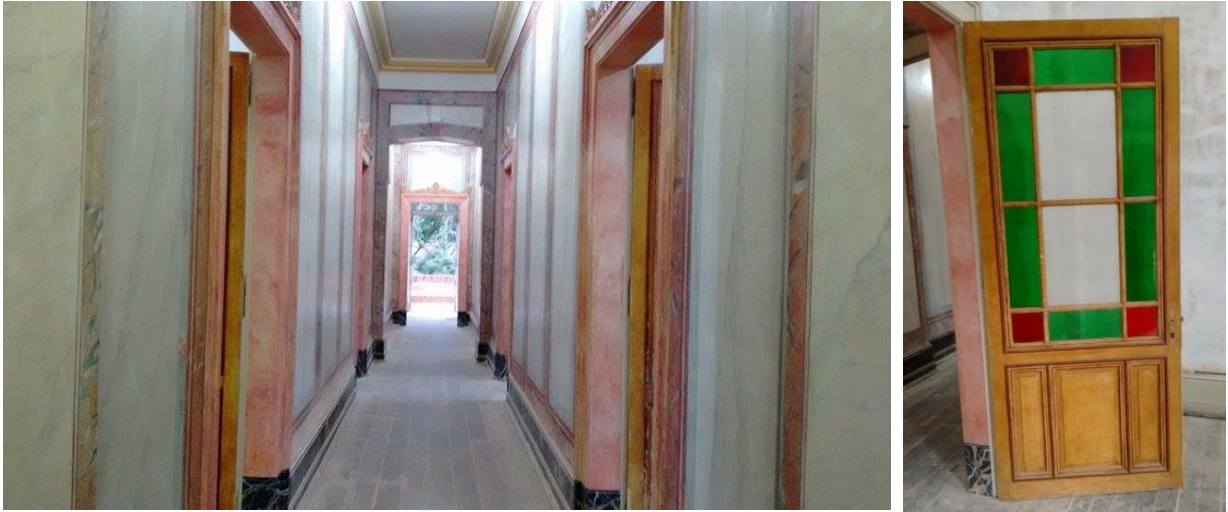
Figura 110 e figura 111: Restauração da pintura das paredes da circulação e Restauração de esquadria.
