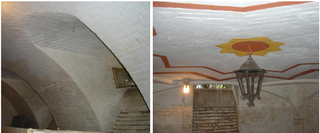
Figura 45 e figura 46: Laje de tjoslos maciços no subsolo.
