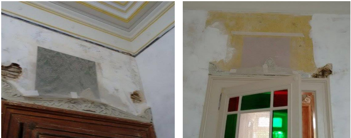
Figura 108 e figura 109: Retirada do papel de parede instalado na década de 1970.
