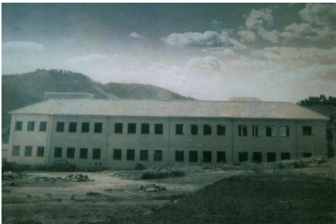
ANEXO X – Foto do prédio do Instituto Jesus na fase final das obras
