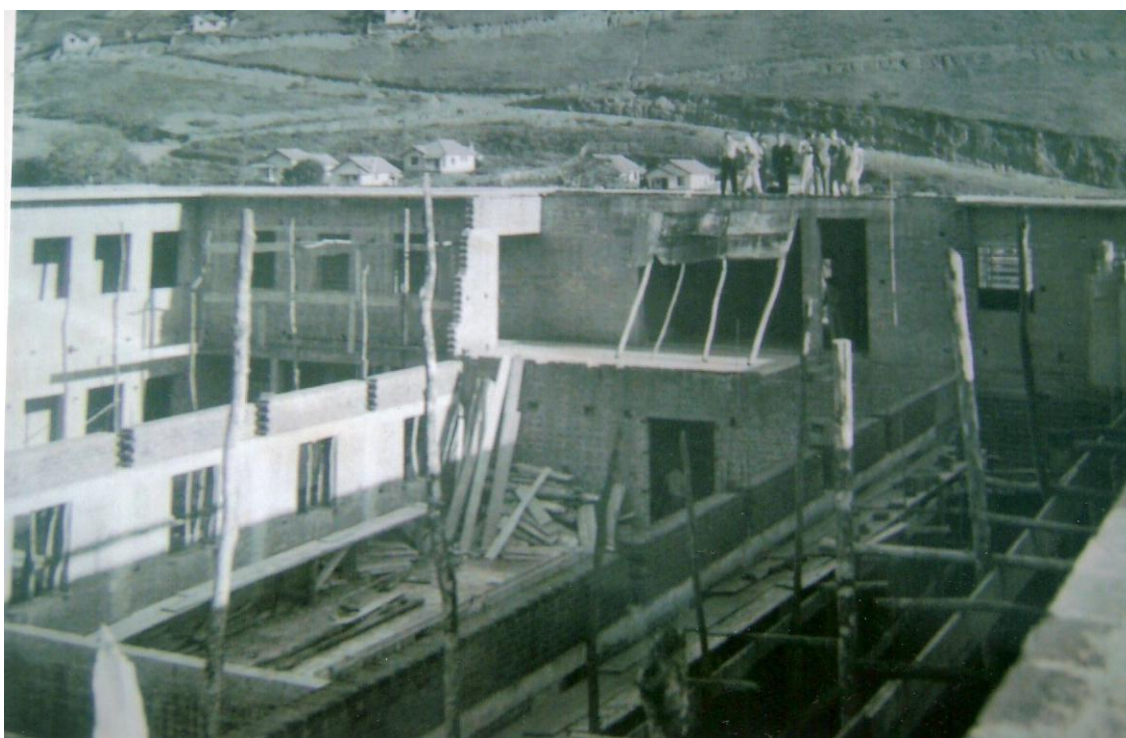
Foto do prédio do Instituto Jesus em obras
