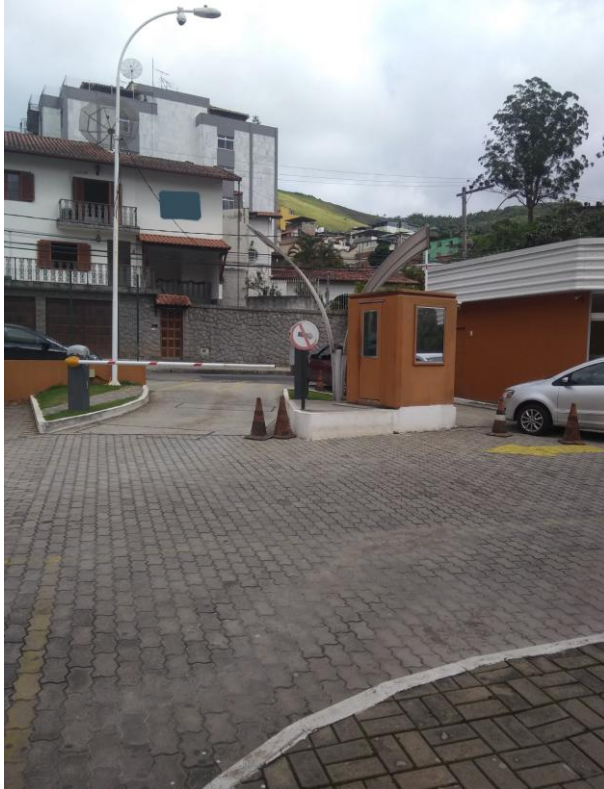
Figura 19 – Acesso ao estacionamento
