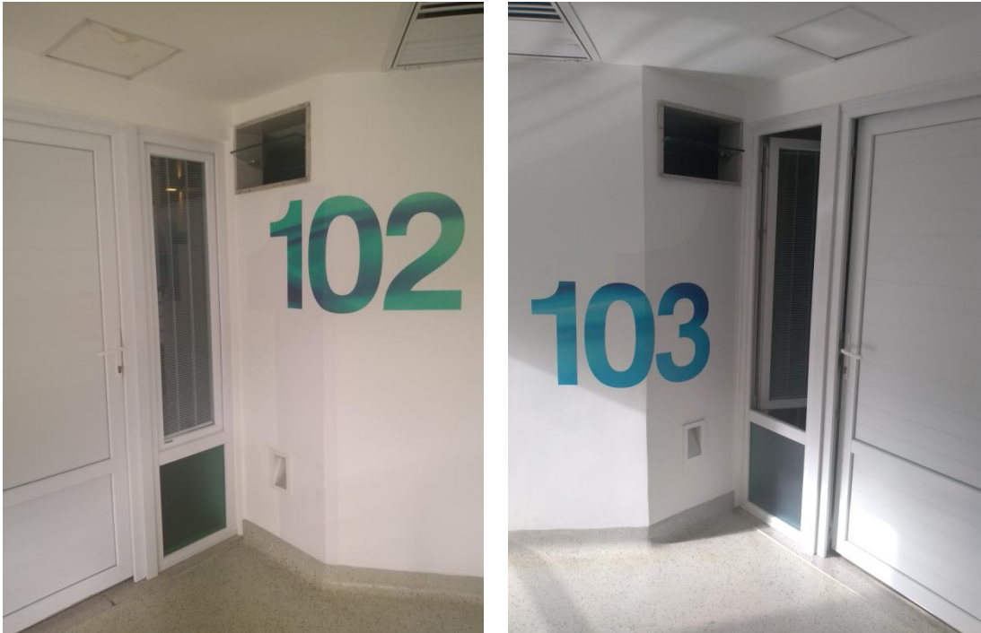
Figura 78 – Corredor externo do 1º pavimento do Hospital B
