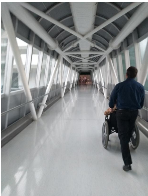
Figura 51 – Panorâmica da Passarela
