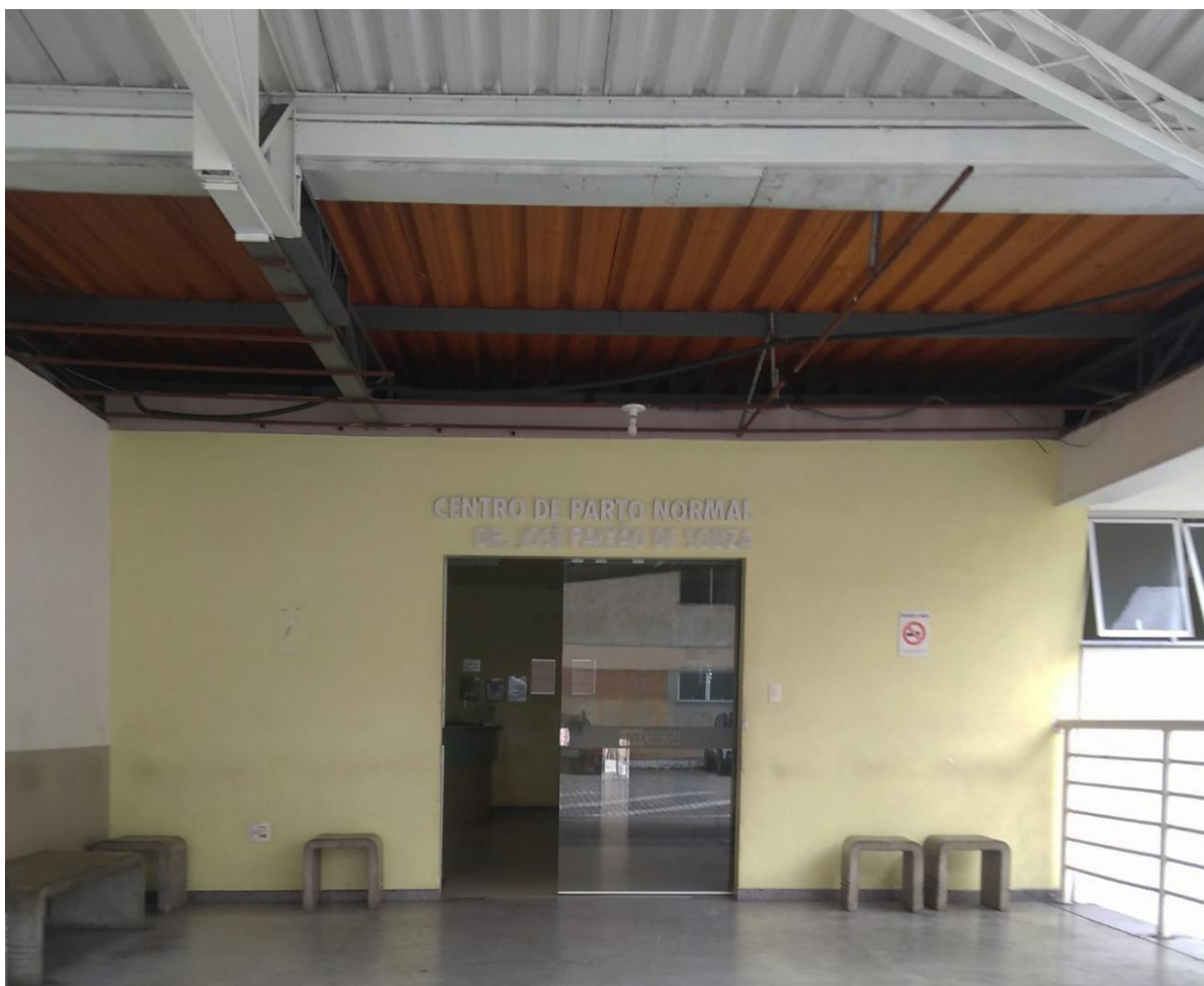
Figura 27 – Detalhe frontal do acesso ao CPN
