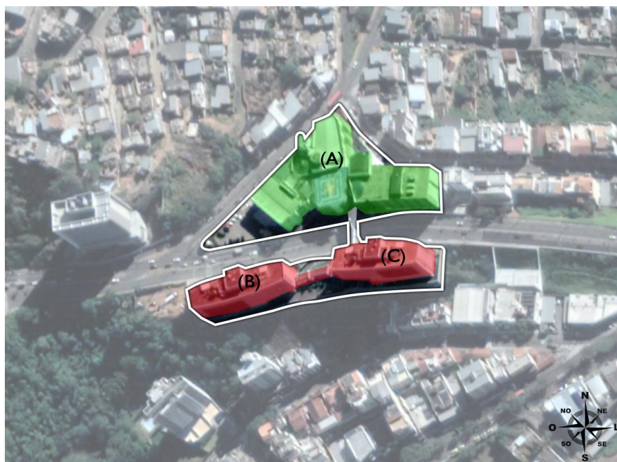
Figura 70 – Vista área do Hospital B
