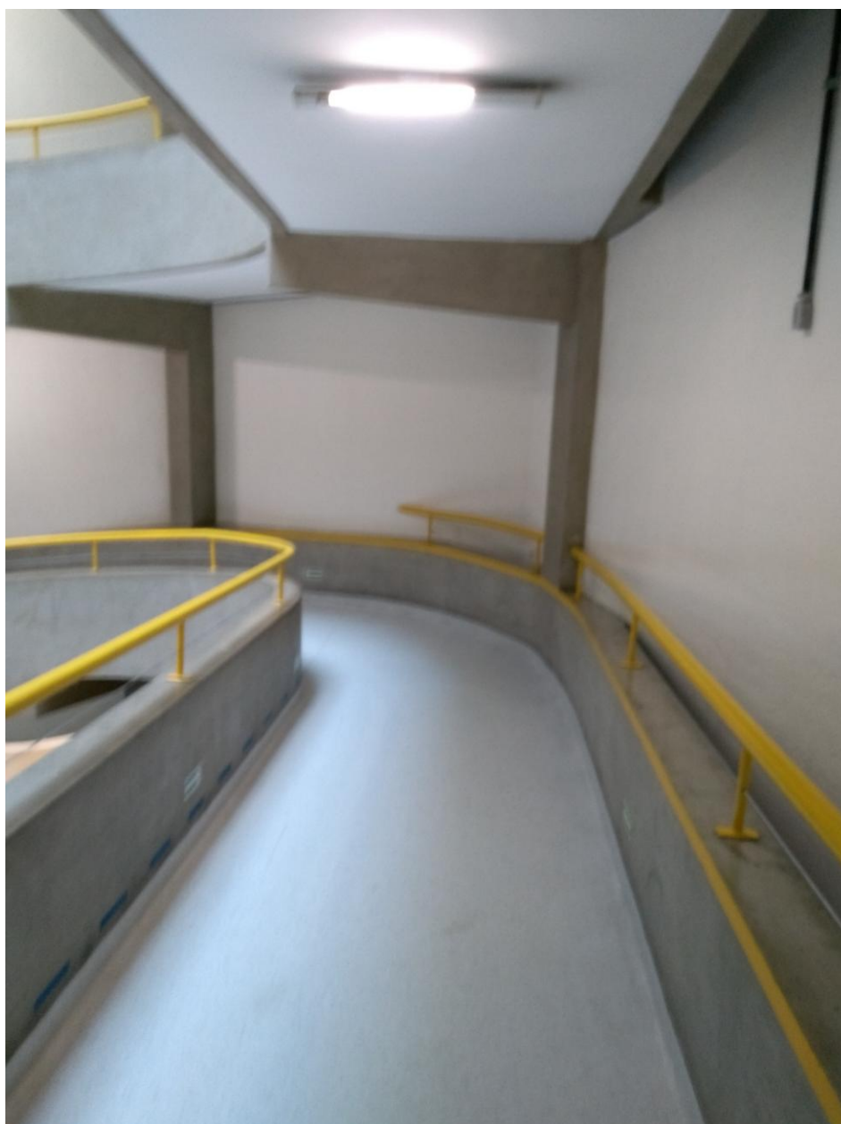
Figura 53 – Rampas de acesso
