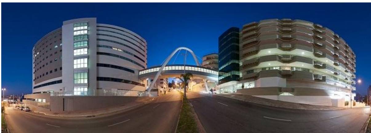
Figura 42 – Vista com grande angular da fachada do Hospital B
