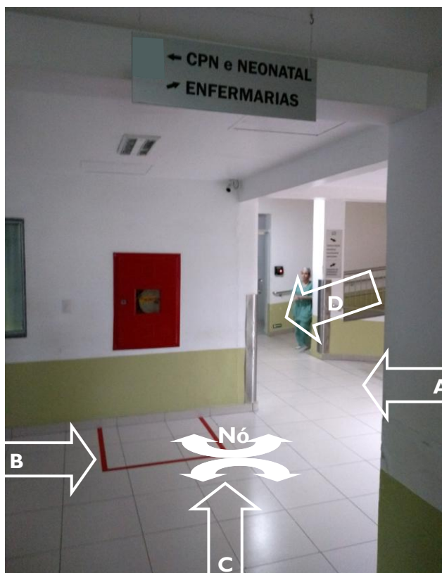
Figura 73 – Nó localizado no pavimento térreo do Hospital A
