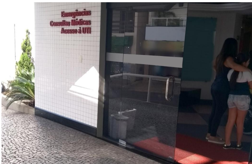
Figura 58 – Acesso da emergência, consultórios e UTI
