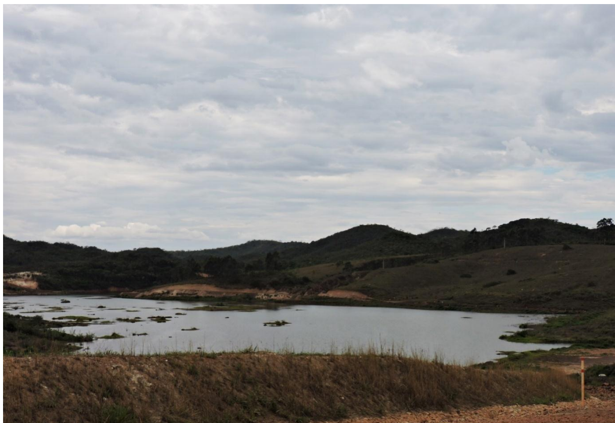
Figura 3 - Foto: Dique S4.
