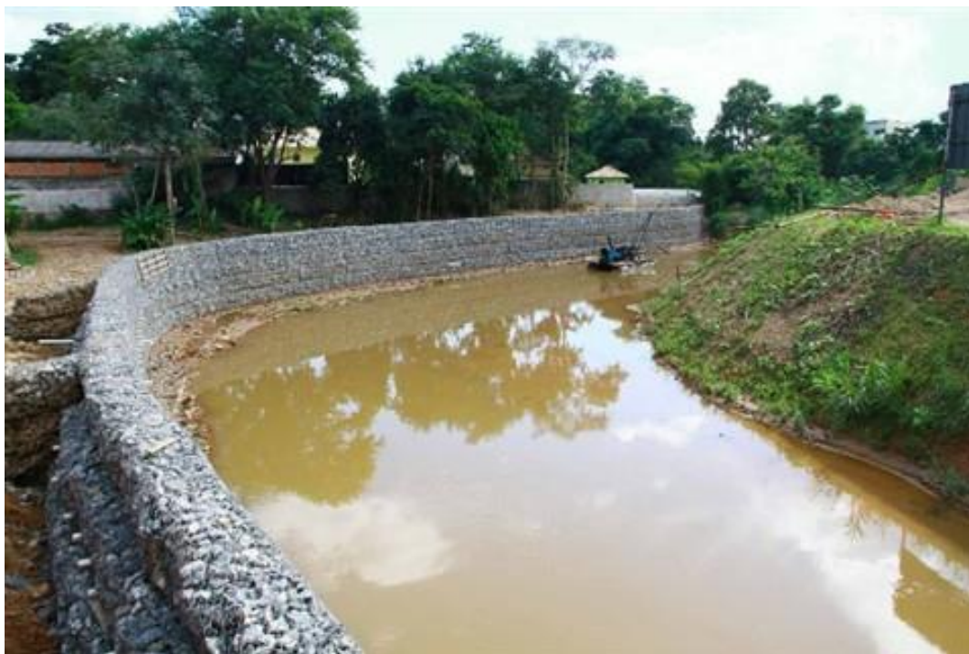
Figura 43: Muros de gabião encontrados ao longo do rio Sesmária, no bairro Parque Ipiranga II Fonte: Jorge Trindade - ACOM PMR (2016).
