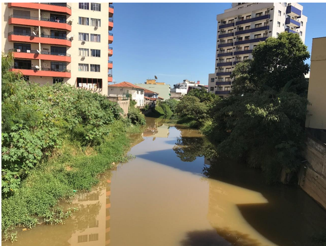
Figura 41: Ocupação nas margens do Rio Sesmaria no centro de Resende.
