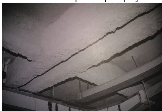
Figura 41 – revestimento de argamassa com vermiculita aplicada por spray.
