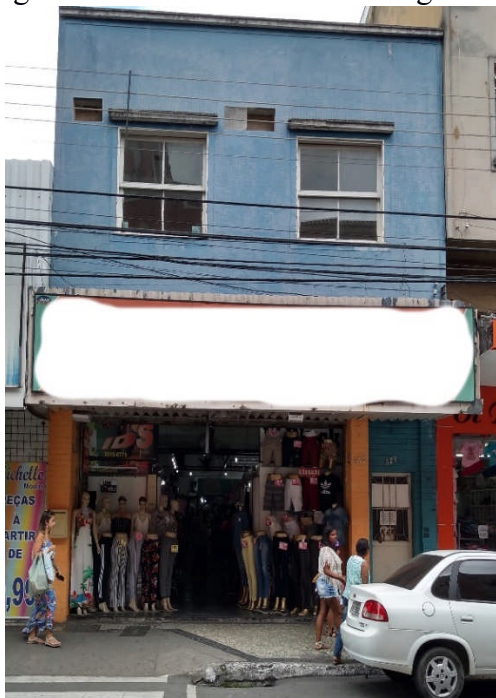
Figura 21 – Vista da fachada da “galeria”
