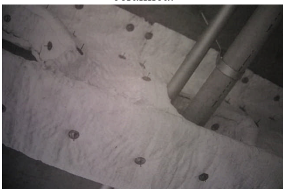
Figura 40 – revestimento de manta cerâmica.
