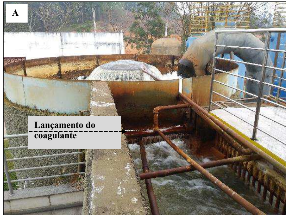
Figura 6 – A) Foto do local de adição do coagulante; e B) Foto da calha Parshall
