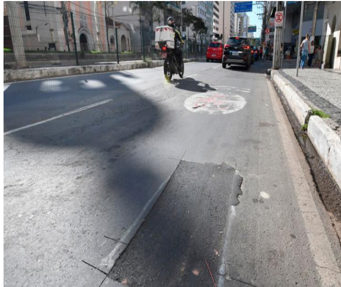
Fotografia 5 - Pavimento na Avenida Barão do Rio Branco
