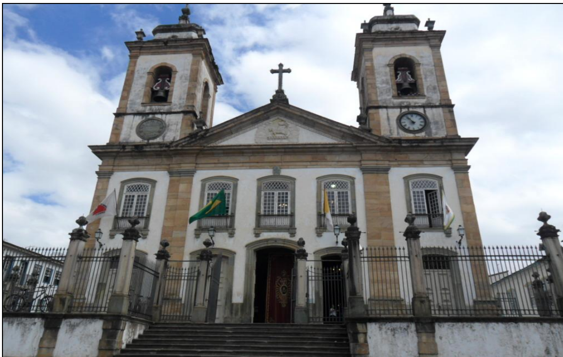
Figura 1 - Catedral Basílica de Nossa Senhora do Pilar, São João Del Rei
