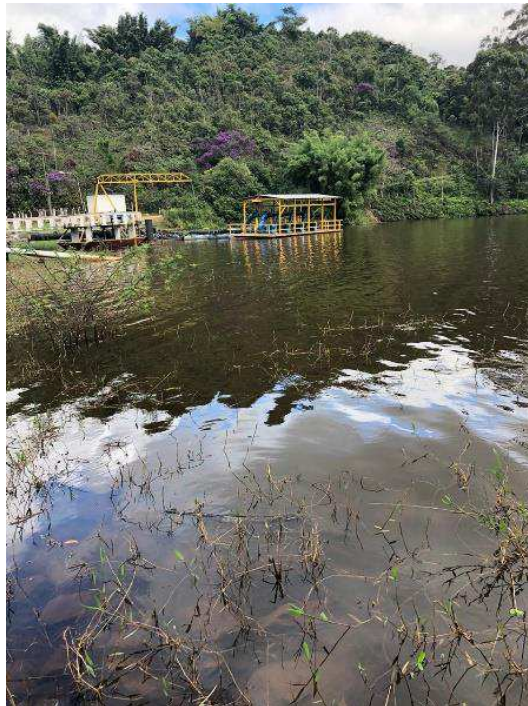
Figura 8 – Fotografia do P6 evidenciando a captação
