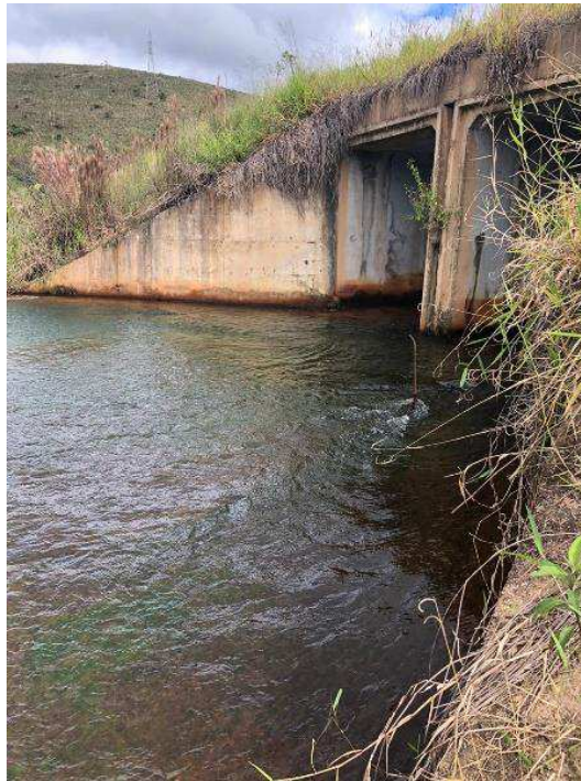
Figura 5 – Fotografia do P3 evidenciando bueiro duplo sob a Rodovia AMG-3085
