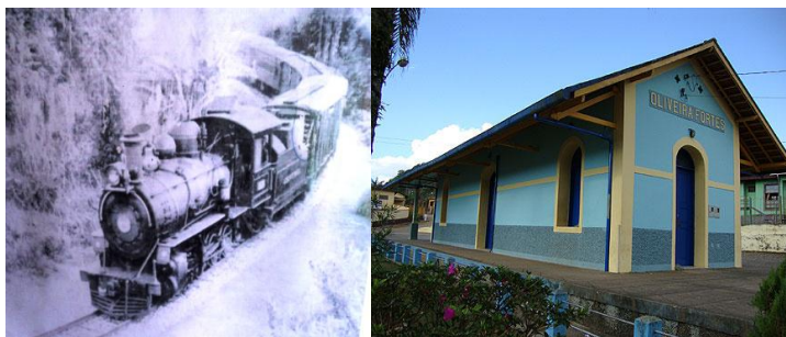
Figura 6 - “Piranguinha” e Estação Ferroviária da cidade de Oliveira Fortes-MG (1911-1969), atualmente sede da agência dos Correios
