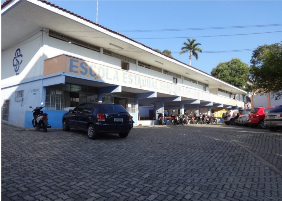
Figura 4 - Acesso da escola
