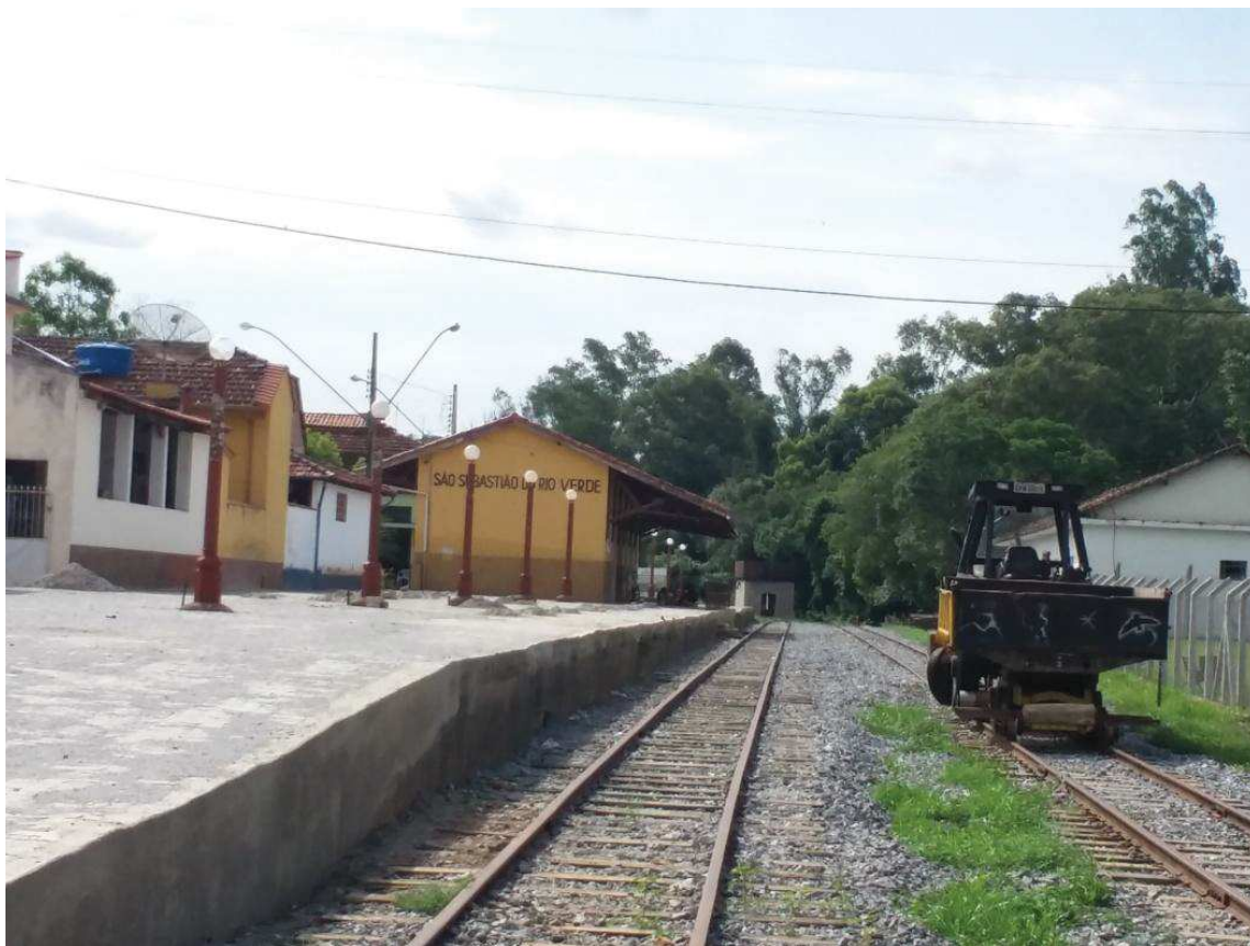
Figura 73: Estação ferroviária de São Sebastião do Rio Verde.
