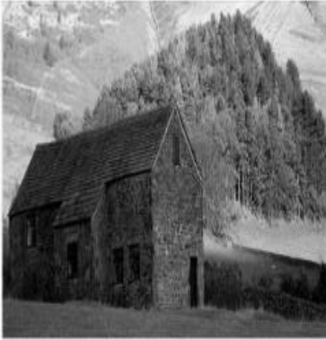
Uma casa de pedra tradicional na vila Edale, Peak District.
