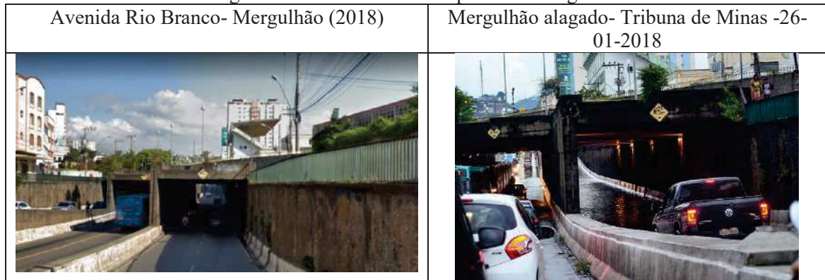
Figura 111: Ocorrência de impacto hidrológico na RP Centro
