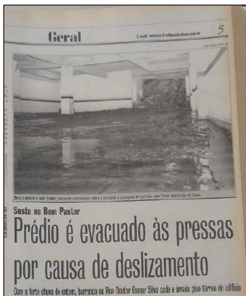
Figura 128: Ocorrência de deslizamento na RU Bom Pastor.
