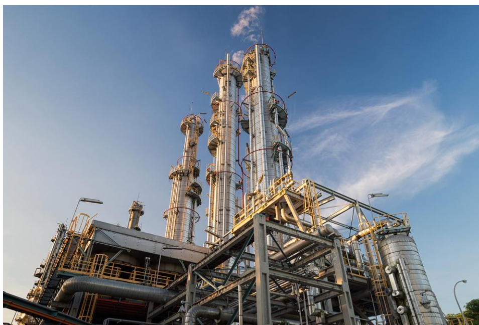
Figura 9 – Torre de Destilação [6]
