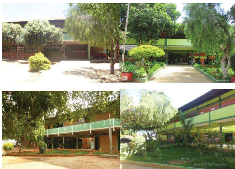
Figura 1 - Fachada da EEPCMD, antes e após os trabalhos de humanização dos espaços escolares feito pela gestão de 2012 até 2020
