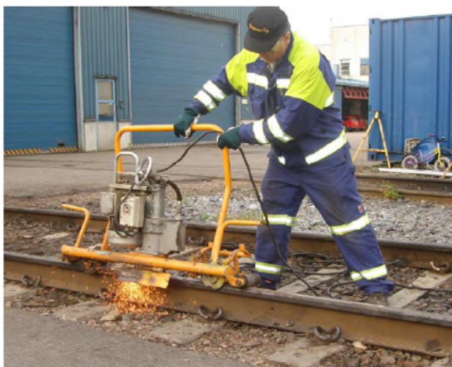
Figura 13 – Acabamento da junta soldada com esmerilhadora elétrica manual
