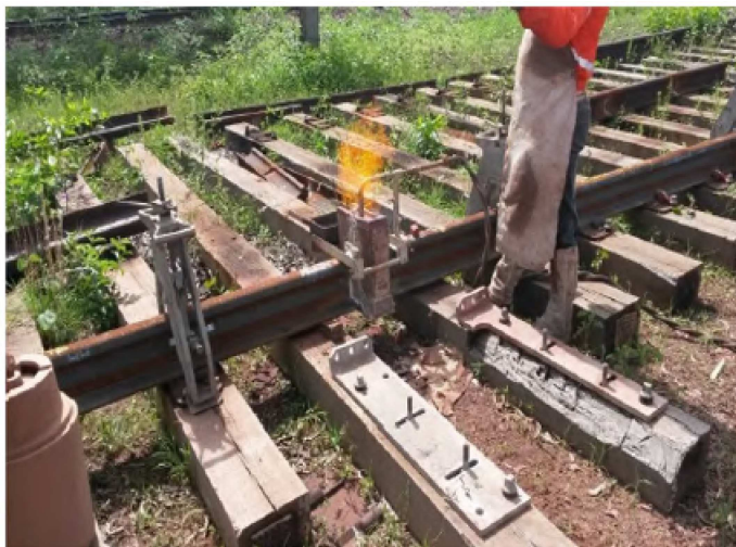
Figura 11 – Pré-aquecimento das juntas soldadas
