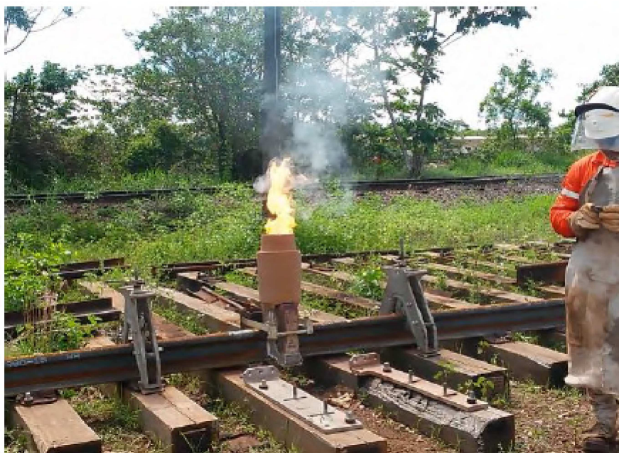
Figura 12 – Realização do processo de Soldagem Aluminotérmica
