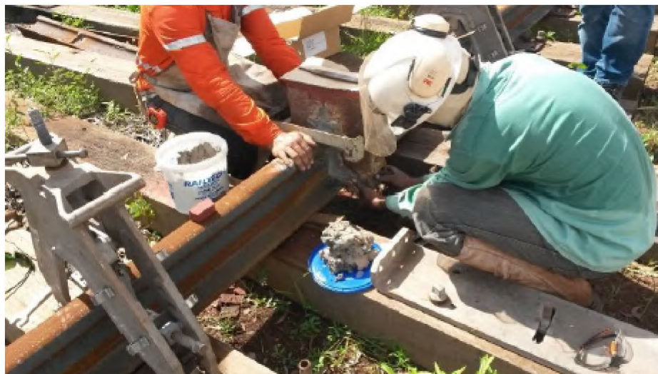
Figura 10 – Aplicação da pasta refratária nas frestas
