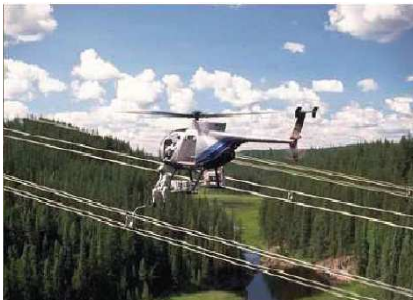
Figura 2 – Inspeção de uma Linha de Transmissão. Fonte: (Martins, 2015)
